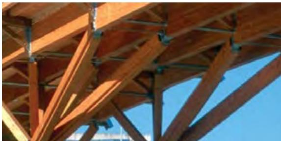
c) Assemblages par tiges insérées collées – Pont de Crest, France
