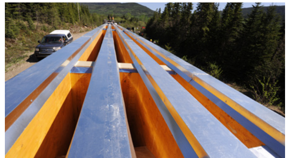
FIGURE 35 - Solin de protection métallique au-dessus de chaque poutre (Source : Forêt Montmorency)
