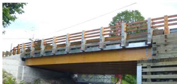
FIGURE 55 - Solin protégeant le platelage
