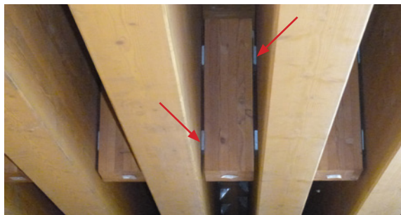
FIGURE 53 - Assemblages de diaphragmes ventilés (facultatif)
