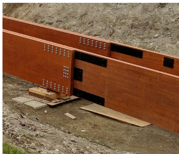
FIGURE 4 - Exemple d'une épissure par trois plaques d'acier - Passerelle Ulrick-Chérubin (Conception : Denis Lefebvre, Crédit photo : Jean-Sébastien Paul)
