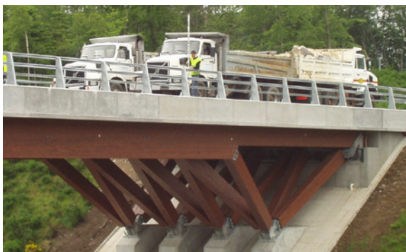
FIGURE 20 - Assemblages protégés sous le platelage étanche (Aire de Chavanon, France) (Source : Arborescence s.a.r.l.)
