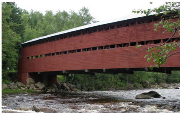
FIGURE 22 – Pont couvert de St-Placide construit en 1926 (Crédit : Pascal Conner)
