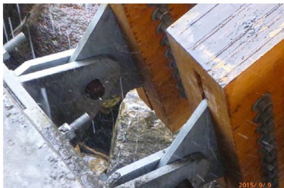
FIGURE 47 - Protection des entailles
