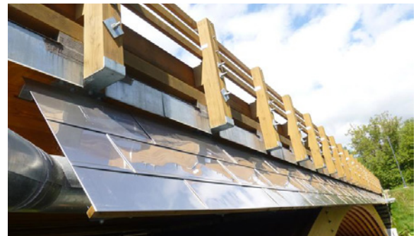
FIGURE 38 - Élément de protection sacrificiel et facilement démontable.
