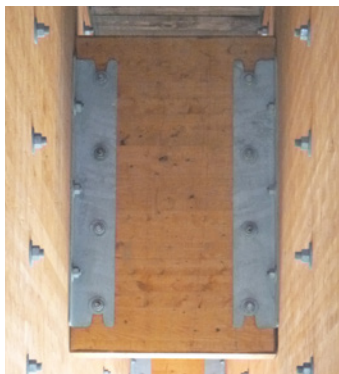
FIGURE 48 - Assemblages avec des cornières
