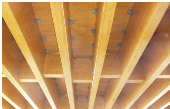
FIGURE 49 - Assemblage des diaphragmes en quinconce
