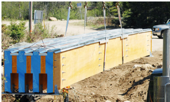
FIGURE 41 - Groupe de poutres droites préassemblées en usine (Crédit : Marc Robitaille)
