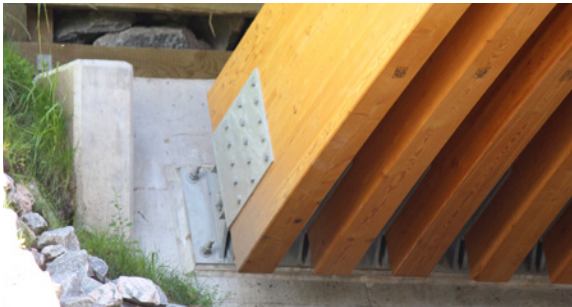
FIGURE 43 - Muret de béton protégeant les appuis
