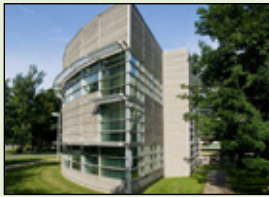
Laboratoire de l'Est de Forintek Canada Corp. à Québec © Cecobois
