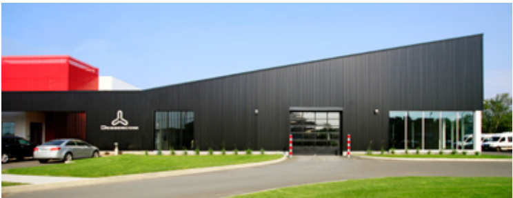
Dessercom Photo : © Alexandre Guérin, STGM architectes
