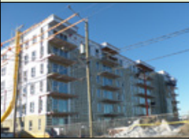
PAL6 à Québec (6 étages) © Douglas Consultants Inc.
