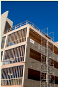
Édifice de la CSN Fondation à Québec (6 étages) © Cecobois
