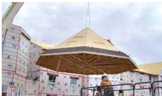
FIGURE 10 • Fermes de toit assemblées au sol
