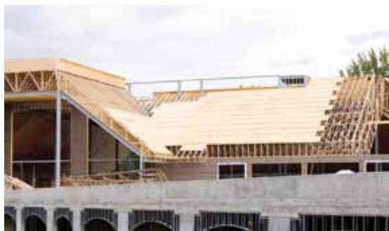
FIGURE 6 • Fermes de toit légères en bois
