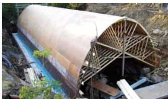
FIGURE 7 • Fermes pour un coffrage
