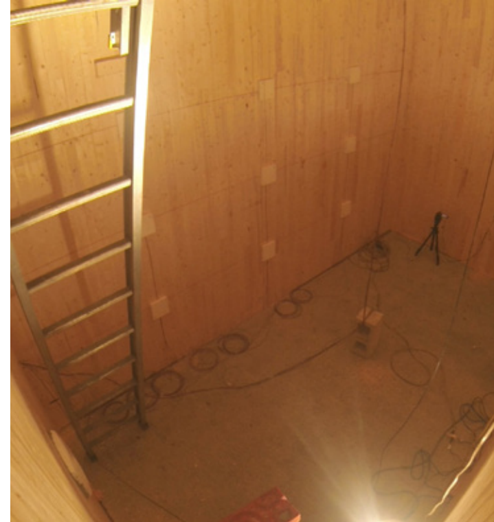
Intérieur de la cage d'escaliers à la fin du test de démonstration © Photo : Nordic Structures
