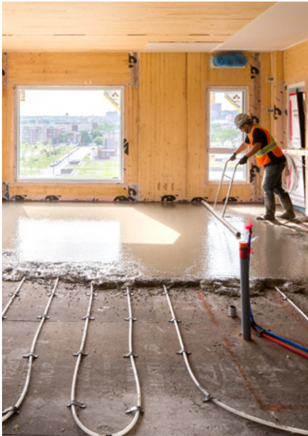
Coulage de la couche de béton sur le plancher radiant © Photo : Stéphane Groleau
