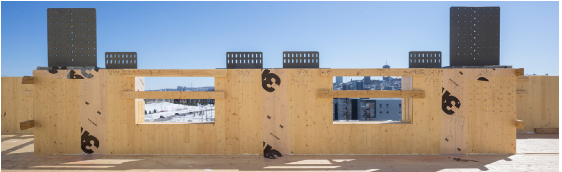
L'utilisation des panneaux de CLT permet d'atteindre de nouveaux sommets
