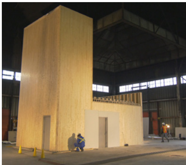
Montage test de démonstration au feu à grande échelle © Photo: Nordic Structures
