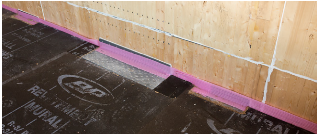
Joints acoustiques entre panneaux de CLT en membrane insonorisante sur le plancher © Photo : Stéphane Groleau
