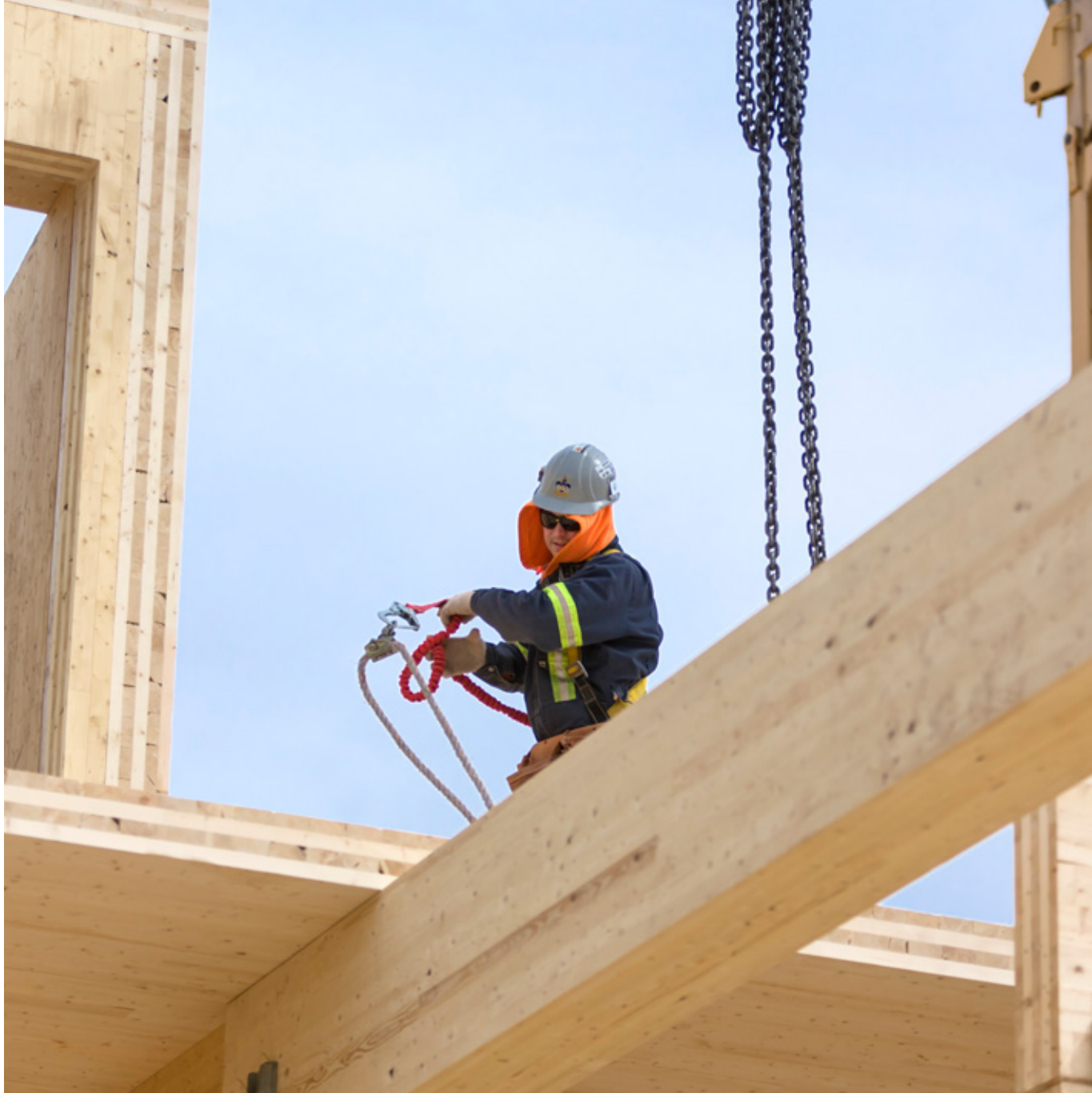
Les pièces de bois arrivent préusinées sur le chantier avec toutes les ouvertures et découpes © Photo : Stéphane Groleau
