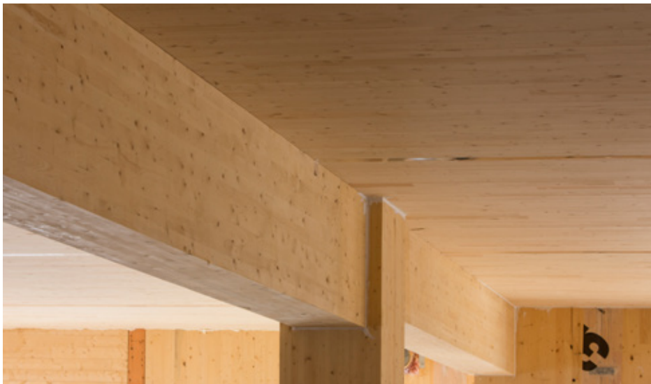
Assemblage poutre-colonne © Photo: Stéphane Groleau
