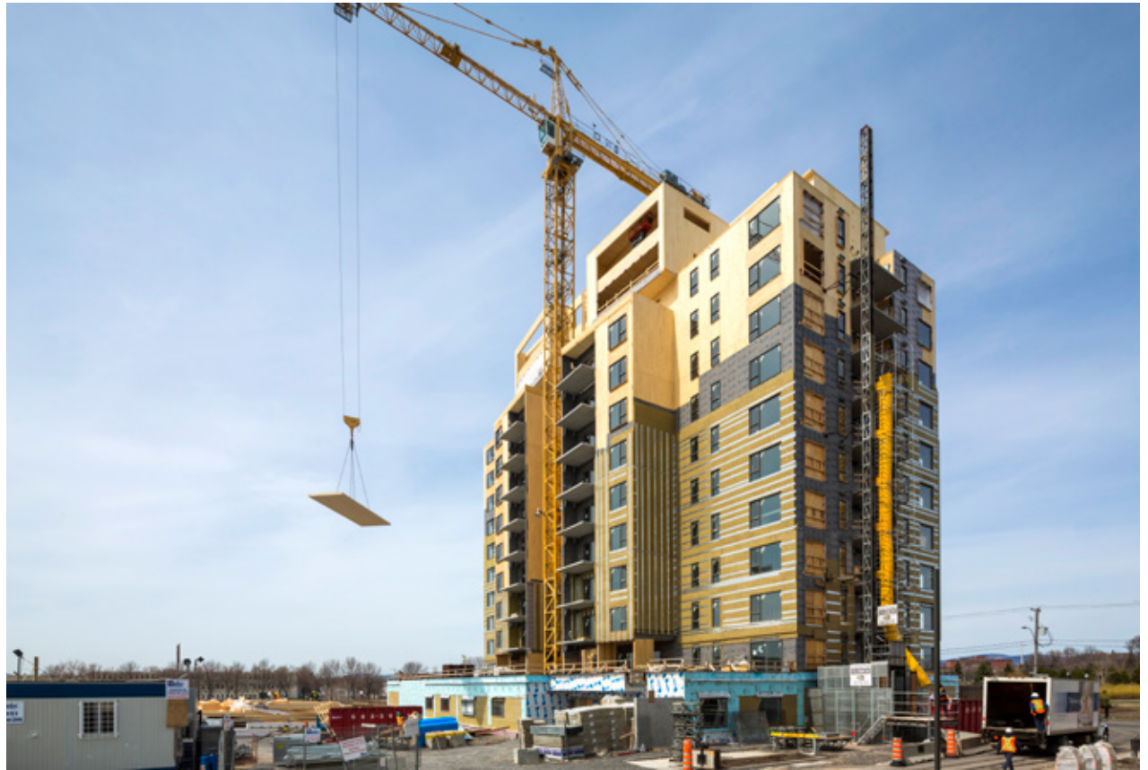
Montage des derniers panneaux © Photo : Stéphane Groleau
