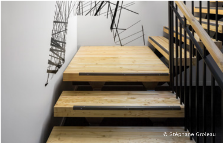
Les marches des escaliers du SIÈGE SOCIAL DE STGM architectes ont été découpées dans une ancienne poutre de bois massif de mélèze (fournisseur : Les Matériauthèques de Montmagny).
