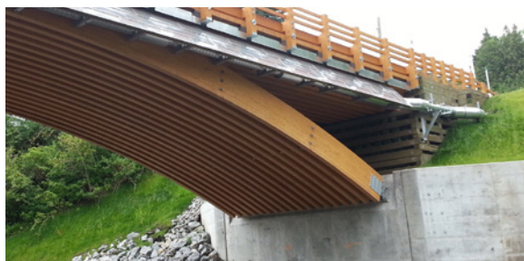
FIGURE 32 - Culée en béton supportant les arches
