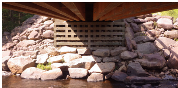
FIGURE 31 – Culée ajourée en bois traité (Source : MFFP)
