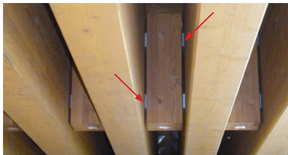
FIGURE 53 - Assemblages de diaphragmes ventilés (facultatif)
