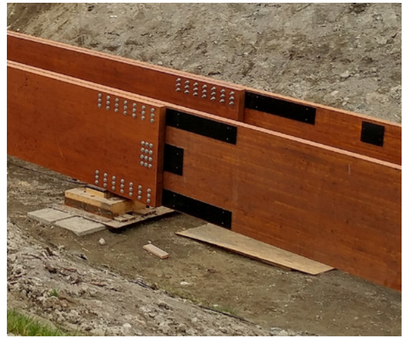
FIGURE 4 - Exemple d'une épissure par trois plaques d'acier - Passerelle Ulrick-Chérubin (Conception : Denis Lefebvre, Crédit photo : Jean-Sébastien Paul)
