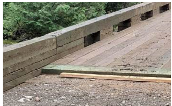
FIGURE 60 - Continuité du platelage et ajout d'un madrier transversal
