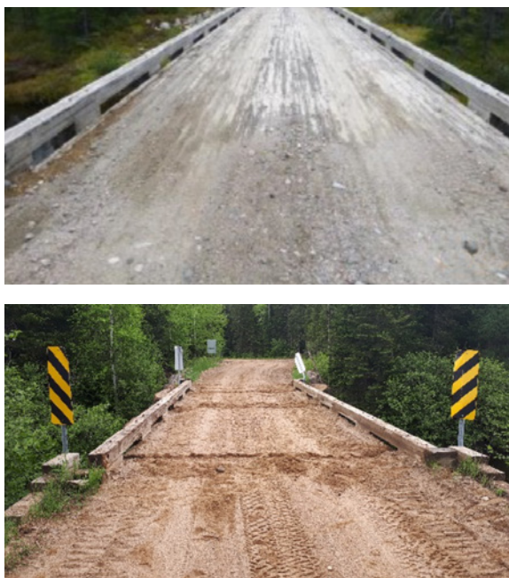
FIGURE 28 - Accumulation de débris sur le tablier (Source : MFFP)
