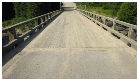
FIGURE 29 - Approche avec enrobé bitumineux (Source MFFP)
