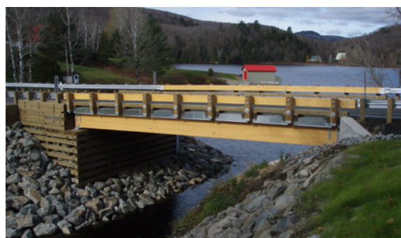
FIGURE 24 - Pont de Sainte-Thècle (Source : Nordic Structures)
