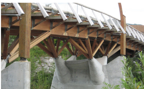
FIGURE 7 – Pont de Crest, 10 ans après sa mise en œuvre (Source : Caroline Frenette)
