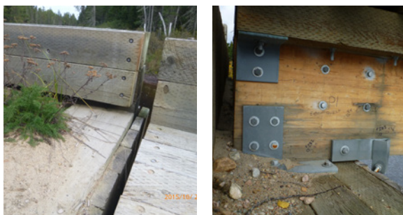
FIGURE 42 - Espace entre la culée et le platelage créant une accumulation de débris
