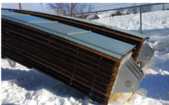
FIGURE 14 - Protection d'arches en bois pour un pont en Norvège (Crédit photo : Alexander Salenikovich)
