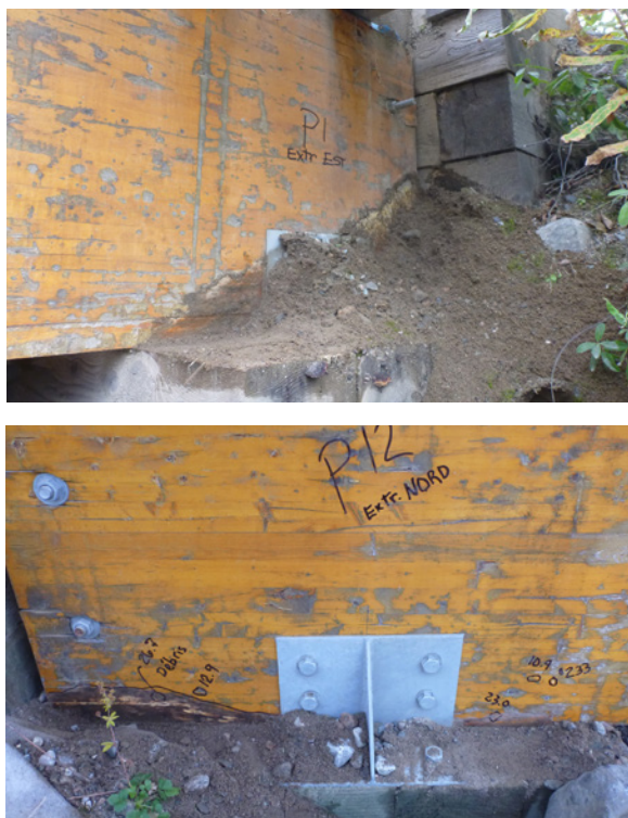
FIGURE 16 - Accumulations de sol et de débris en contact avec le bois (Source: Stantec [5] )
