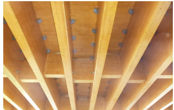
FIGURE 49 - Assemblage des diaphragmes en quinconce
