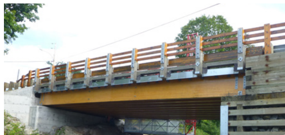
FIGURE 55 - Solin protégeant le platelage
