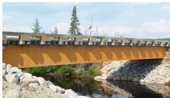
FIGURE 8 - Pont du Poste montagnais, QC (Source : Nordic Structures)
