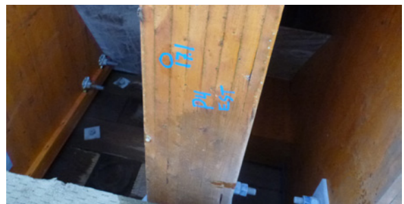
FIGURE 60 - Continuité du platelage et ajout d'un madrier transversal
