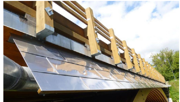
FIGURE 38 - Élément de protection sacrificiel et facilement démontable.
