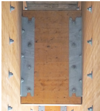
FIGURE 48 - Assemblages avec des cornières
