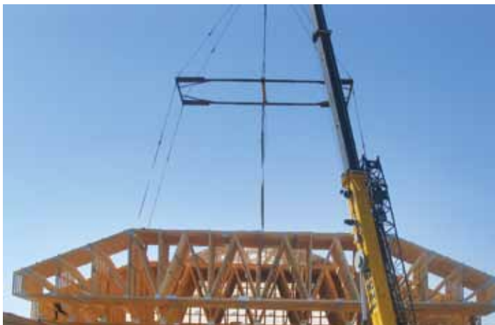
Installation de modules de fermes de toit pré-assemblés au sol
