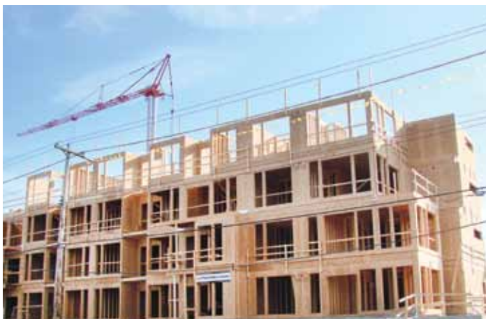
Construction d'un bâtiment de six étages à ossature légère
