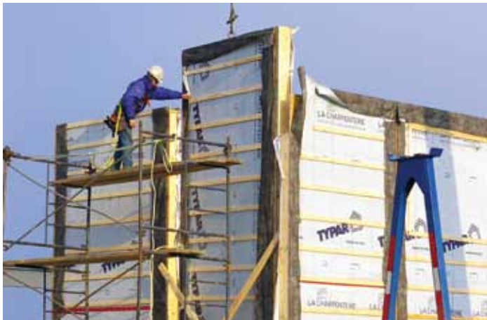
Installation de sections de murs préfabriqués
