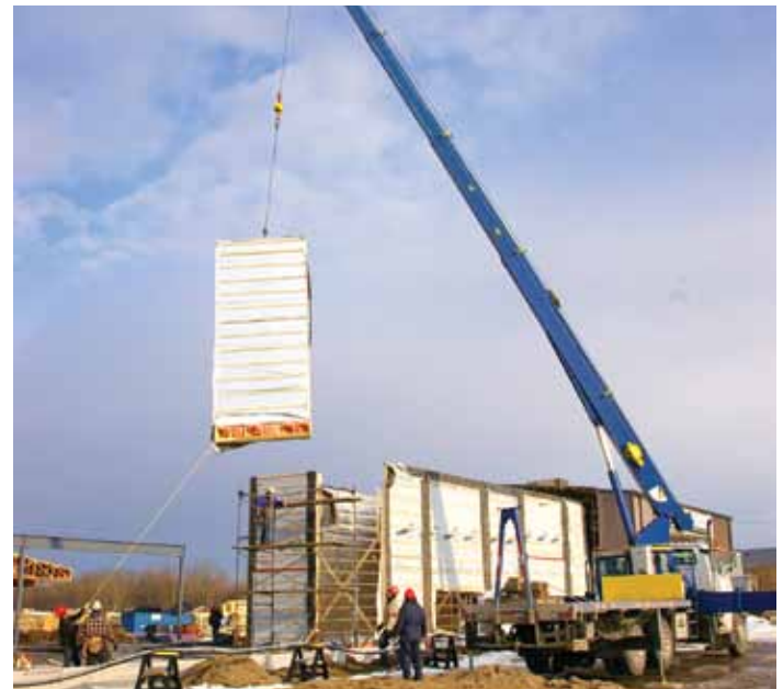
Installation de sections de murs préfabriqués
