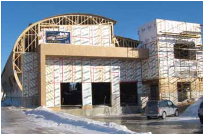
Les fermes légères permettent de créer des profils de toiture quasi illimités
