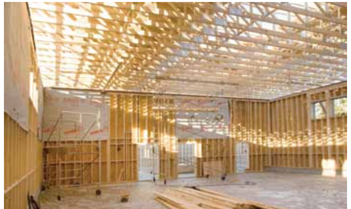
Murs à ossature légère préfabriqués de 4,88 m (16 pi) de hauteur
