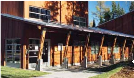
Les colonnes soutenant un large avant-toit sont inclinées vers l'intérieur pour une meilleure protection. Les pieds de colonnes sont bien surélevés au-dessus du sol et assemblés à l'aide de cornières métalliques permettant un bon drainage.
