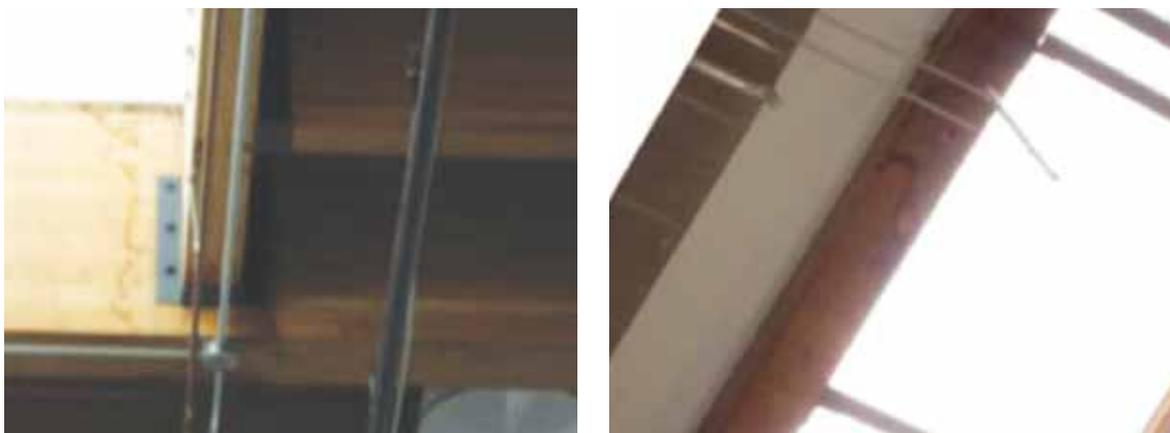
**FIGURE 29** • Écoulement d'eau dû à la condensation sur une surface de verre en toiture
