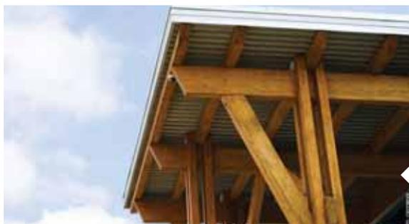
Une structure poteau-poutre extérieure doit être bien protégée par une toiture suffisamment grande et l'extrémité des poutres doit être taillée en biseau vers l'intérieur.
