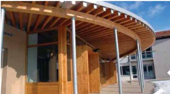
Poutres extérieures en bois protégées par une toiture et des solins de protection en extrémité.
