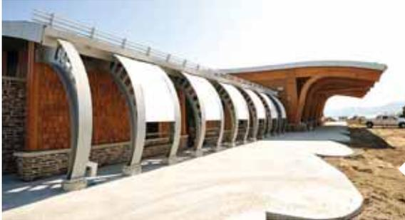
Structure apparente en bois bien protégée par une toiture et des solins de protection.
