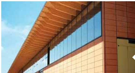
Large avant-toit et chevrons coupés en biseau prononcé permettent d'éviter que l'eau n'entre à l'extrémité du bois.
