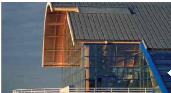
Large avant-toit permettant de bien protéger la structure et la façade.
