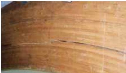
**FIGURE 19** • Délamination d'une poutre courbe en bois lamellé-collé
