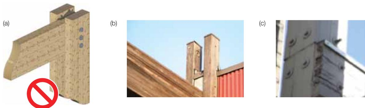
FIGURE 33 • Assemblages poutre-poteau à éviter en utilisation extérieure
