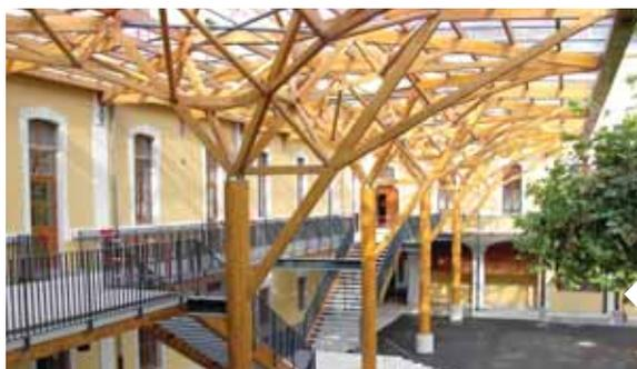
La structure apparente en bois est couverte par une toiture en verre, les colonnes sont situées dans un espace bien protégé, et les pieds de colonnes sont bien surélevés au-dessus du niveau du sol. (La toiture en verre ne cause pas de problème de condensation car elle ne divise pas un espace chaud d'un espace froid.)
