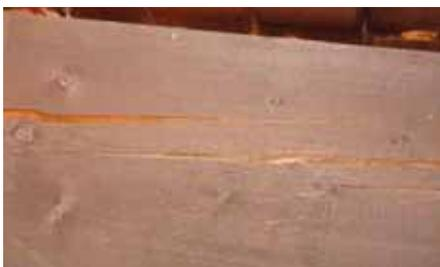
**FIGURE 18** • Gerce importante dans une poutre en gros bois d'œuvre
