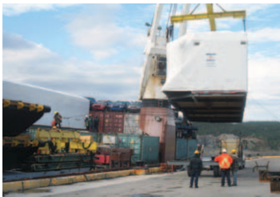
FIGURE 44 • Modules en chargement vers le bateau
