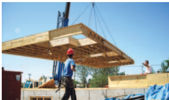
FIGURE 8 • Section de plancher préfabriquée (Batitech)
