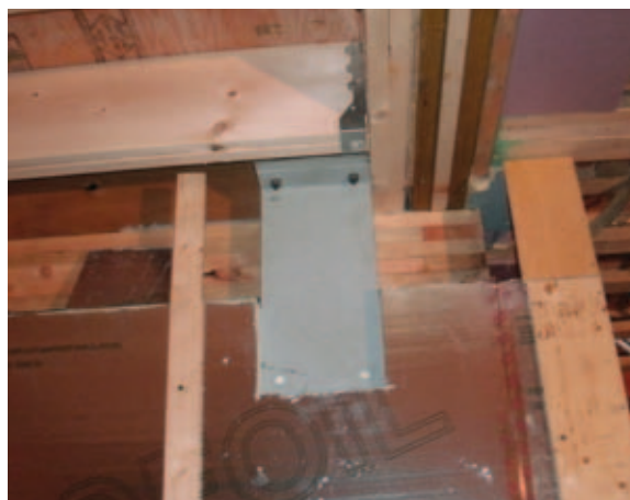
FIGURE 27 • Système d'ancrage à plaques d'acier soudées
