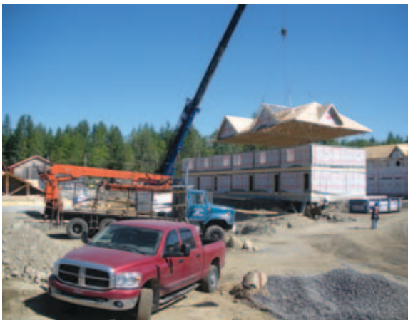
FIGURE 6 • Section de toiture (à gauche) et panneaux (à droite) (Batitech)
