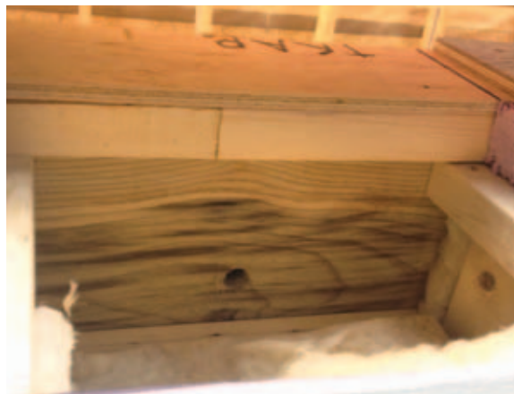
FIGURE 28 • Section de plancher non finie
