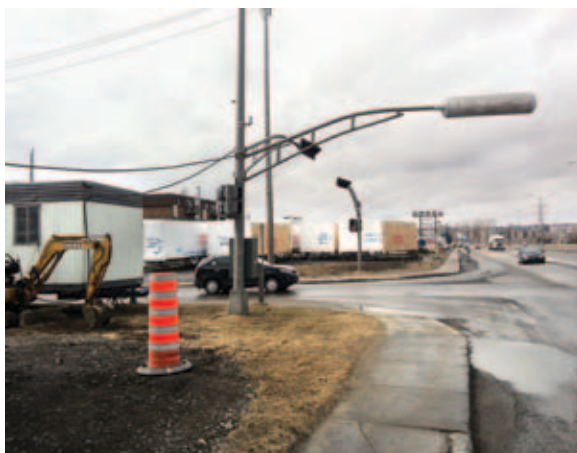
FIGURE 42 • Photo de modules emballés sur le terrain en attente d'érection
