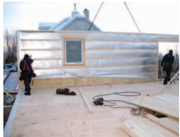
FIGURE 6 • Section de toiture (à gauche) et panneaux (à droite) (Batitech)
