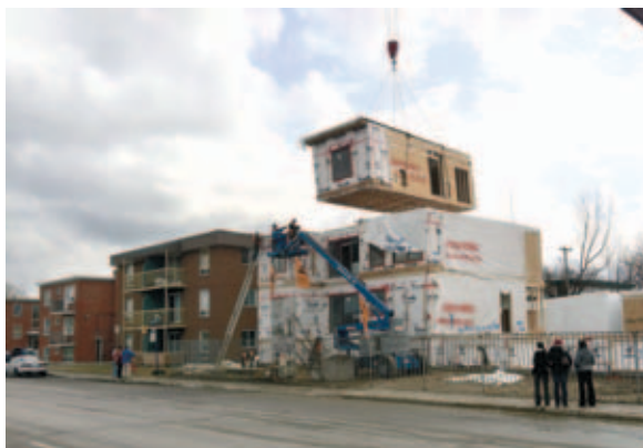
FIGURE 47 • Installation d'un module à la grue
