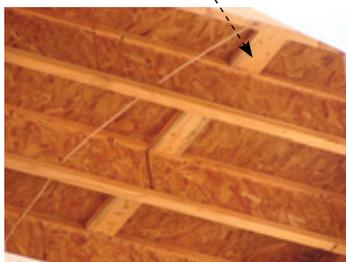
Selon le tableau de la page 440 du MCCB 2010, pour des clous ordinaires de 3 po (3,66 mm de diamètre), des panneaux de bois de 15,5 mm d'épaisseur, des largeurs de membrures de 38 mm et pour un clouage tel qu'indiqué à la **figure 29**, la résistance du diaphragme est  $V_r = 8,4 \text{ kN/m}$ .
