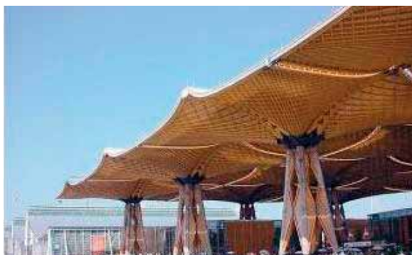
FIGURE 50 • Résille en bois LVL lors de l'expo Dach à Hanovre (Allemagne) ( www.finnforest.de )
