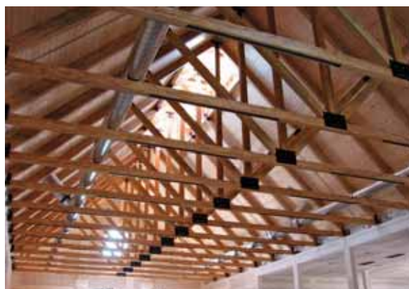
FIGURE 45 • Fermes triangulées en bois PSL (photo : Weyerhaeuser)
