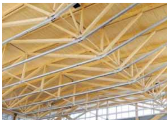
FIGURE 46 • Fermes hybrides bois-acier (Centre de tri des matières résiduelles de Roberval)
