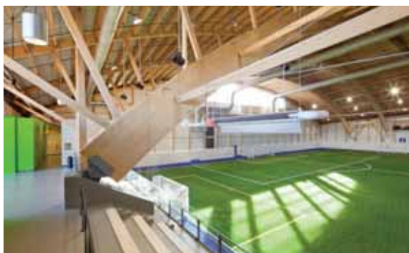
FIGURE 24 • Arche circulaire du Stade de soccer Chauveau à Québec (photo : Stéphane Groleau)
