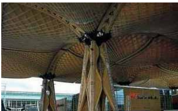
FIGURE 50 • Résille en bois LVL lors de l'expo Dach à Hanovre (Allemagne) ( www.finnforest.de )
