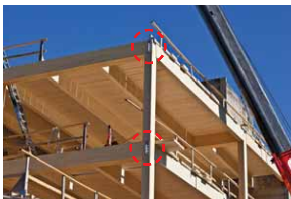
FIGURE 41 • Continuité des colonnes
