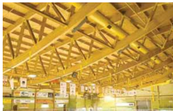
FIGURE 44 • Fermes en bois lamellé-collé (aréna de Saint-Gabriel-de-Brandon)
