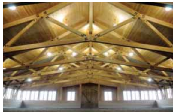
FIGURE 43 • Fermes triangulées en bois massif
