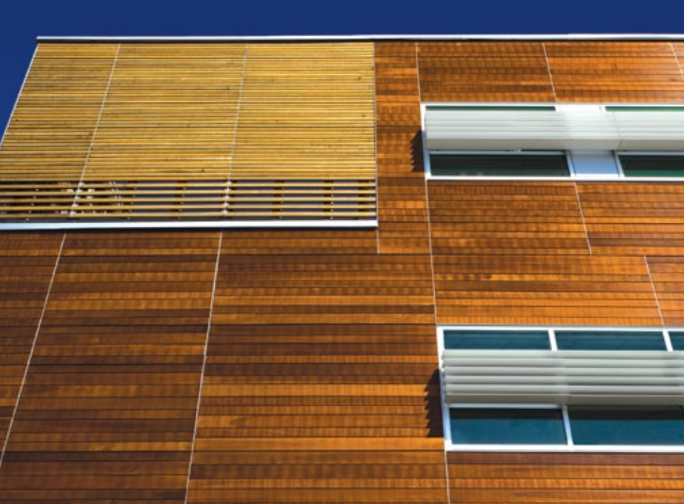
Le revêtement en peuplier modifié thermiquement du Quartier général de la Sûreté du Québec, district MLLL, est plus résistant à la dégradation fongique que le bois naturel. Le revêtement teint en usine, dans des conditions optimales, offre également une meilleure protection contre les rayons UV. Architectes : Services intégrés Lemay et associés inc. et Jean-Marc Coursol architecte. Photo : Stéphane Brügger.
