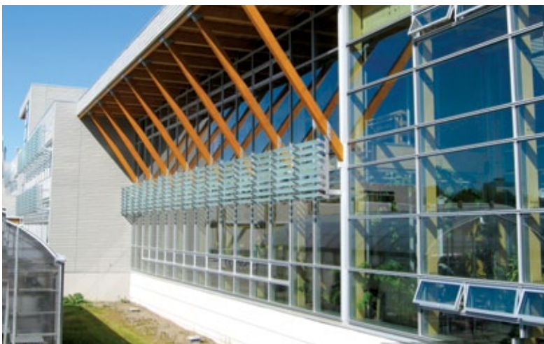
Les contrefiches extérieures en bois du Pavillon Gene-H.-Kruger de l'Université Laval, construit en 2004, permettent de soutenir un large avant-toit tout en étant bien protégées, car elles sont fortement inclinées vers l'intérieur. Architectes : Les architectes Galiene et Moisan (maintenant ABCP Architecture) et Paul Gauthier, architecte
