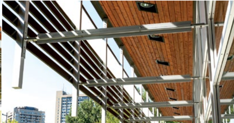
Les débords de toit suffisamment larges et les brise-soleil du Terminal de collecte des matières résiduelles, à la Cité Verte, permettent de réduire l'exposition directe du revêtement avec la pluie. Architectes : BMD architectes inc. Photode gauche : BMD architectes inc. Photo de droite : Pierre Soulard
