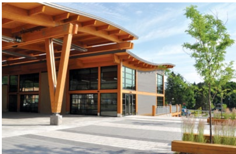
Les éléments structuraux extérieurs en bois lamellé-collé de la Place des citoyens à Sainte-Adèle sont conçus de façon à assurer leur pérennité : débords de toit suffisamment larges, colonnes inclinées, extrémité des poutres coupée en biseau et surélévation minimale de 30 à 40 cm des pieds de colonnes. Architectes et photo : Atelier IDEA
