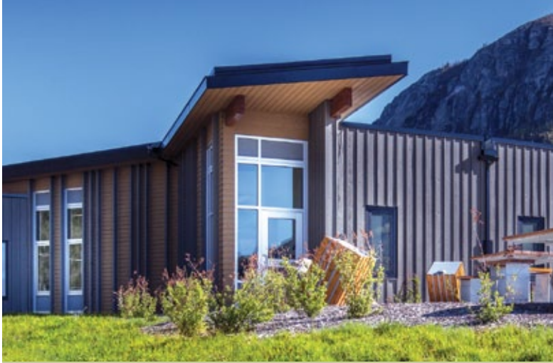
Les poutres extérieures du Centre de services du Mont-du-Lac-des-Cygnés sont placées en retrait pour être bien protégées sous l'avant-toit. Architectes : BGLA architecture et design urbain Photo : Marjorie Roy
