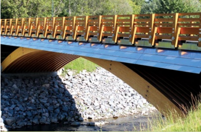
Les poutres en arches du pont Bishop, à Portneuf, sont bien protégées sous le prolongement des tabliers. Architecture et ingénierie : Ministère des Transports du Québec Structure : Goodfellow
