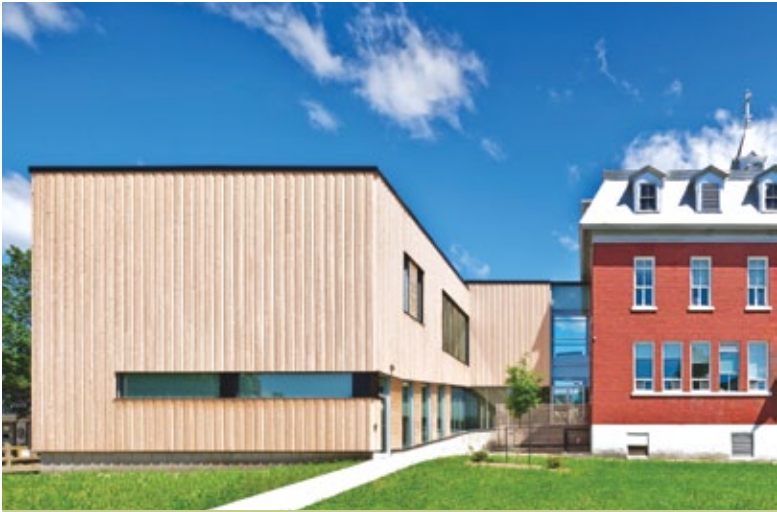
Un dégagement minimal d'au moins 200 mm au-dessus du sol permettra d'assurer la pérennité du revêtement de l'Institut des sciences de la forêt tempérée (ISFORT). Architectes : BGLA inc. Photo : Marc Cramer
