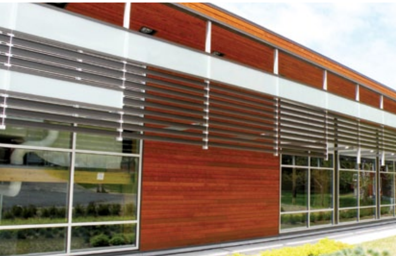
Les débords de toit suffisamment larges et les brise-soleil du Terminal de collecte des matières résiduelles, à la Cité Verte, permettent de réduire l'exposition directe du revêtement avec la pluie. Architectes : BMD architectes inc. Photode gauche : BMD architectes inc. Photo de droite : Pierre Soulard
