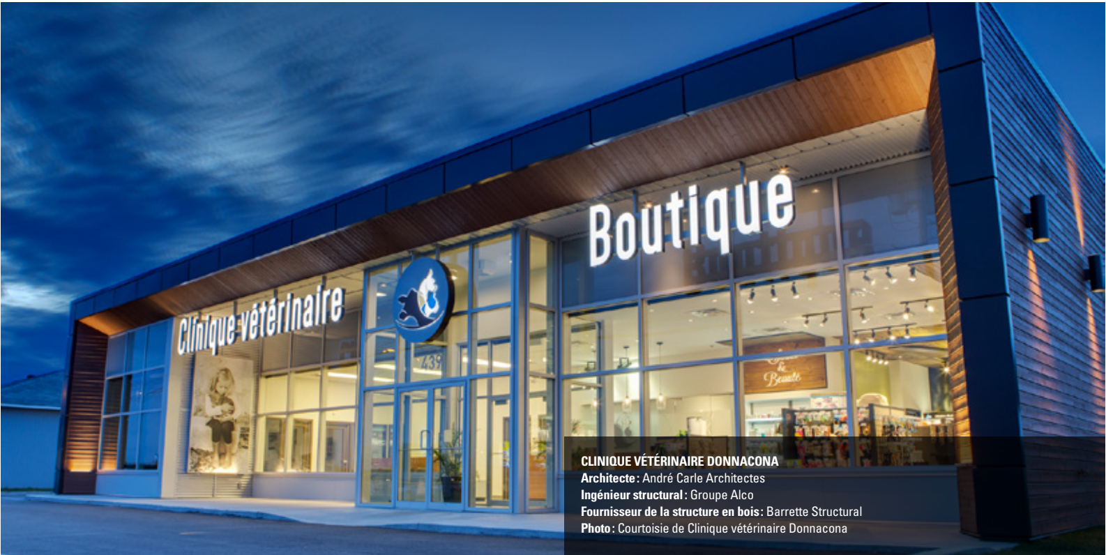
CLINIQUE VÉTÉRINAIRE DONNACONA Architecte : André Carle Architectes Ingénieur structural : Groupe Alco Fournisseur de la structure en bois : Barrette Structural Photo : Courtoisie de Clinique vétérinaire Donnacona
