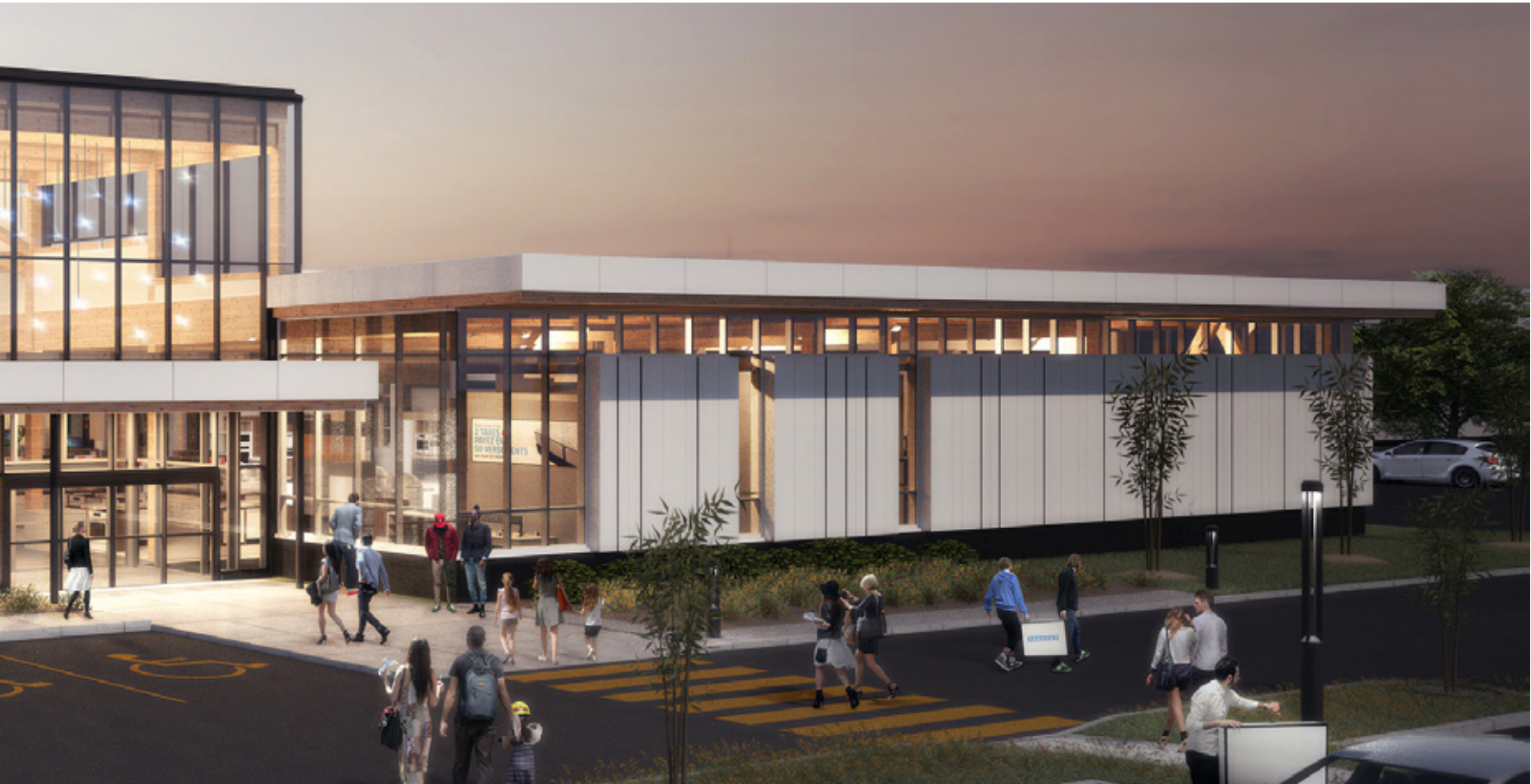
CLINIQUE VÉTÉRINAIRE DONNACONA Architecte : André Carle Architectes Ingénieur structural : Groupe Alco Fournisseur de la structure en bois : Barrette Structural Photo : Courtoisie de Clinique vétérinaire Donnacona
