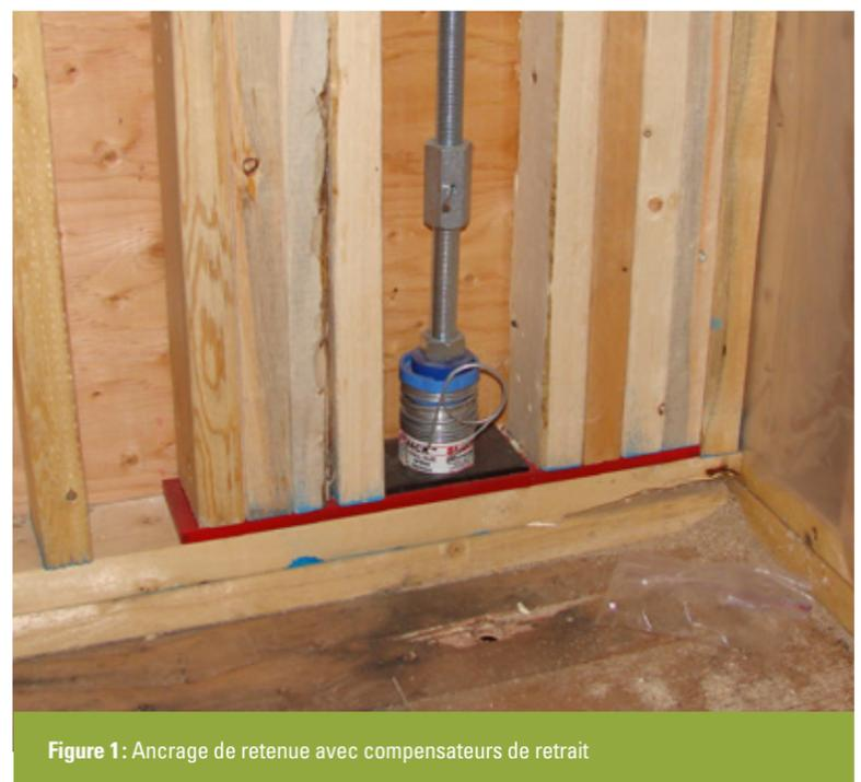
Figure 1 : Ancrage de retenue avec compensateurs de retrait
