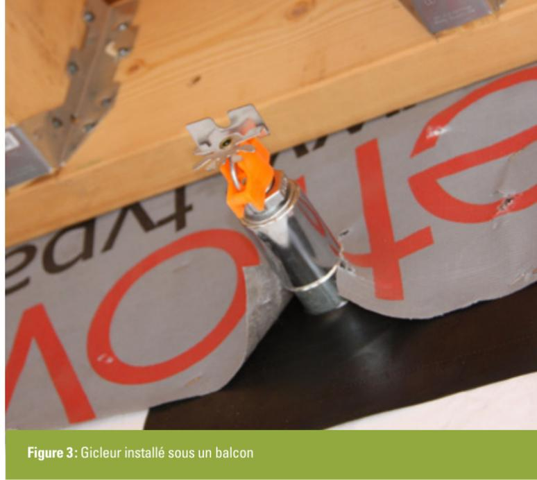
Figure 3: Gicleur installé sous un balcon
