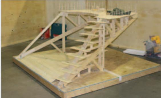
Deux fermes triangulées disposées en angle soutiennent la plateforme en porte-à-faux et assurent la résistance latérale. Cette structure simple et efficace permet de minimiser les points d'appui au sol.
