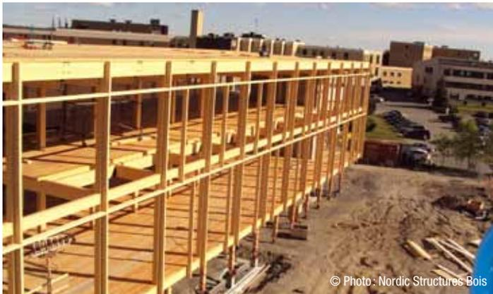
Les colonnes les plus grosses ont des dimensions de 222 × 279 mm, tandis que les poutres principales font 137 × 686 mm. Il s'agit de poutres doubles qui, au lieu d'être collées ensemble, passent de chaque côté des colonnes et sont liées par une connexion métallique, un premier élément de complexité. L'avantage de ces poutres doubles est à la fois de paraître moins massives et de permettre le passage de la mécanique de ventilation dans l'espace entre elles.
