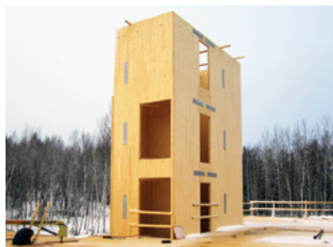
FIGURE 78 • Exemple d'une gaine d'ascenseur en panneaux massifs lamellé-croisés (CLT) (Photo: Nordic Structures)
