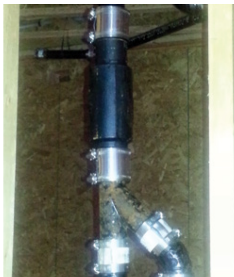
FIGURE 84 • Manchons de plomberie permettant le retrait
