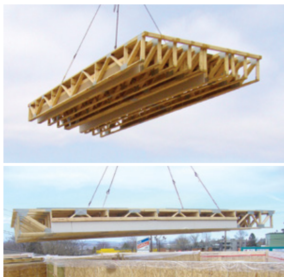
FIGURE 101 • Exemples de sections de plancher préfabriquées (Photos : Structures RBR)
