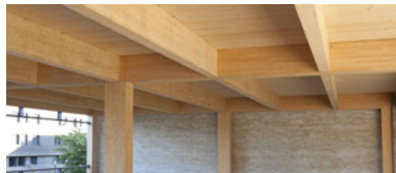
FIGURE 32 • Exemple d'attaches métalliques dissimulées à l'intérieur des pièces de bois (Photo : Cecobois)
