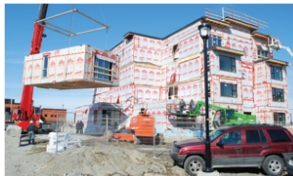
FIGURE 103 • Construction modulaire (Photo : Industries Bonneville)
