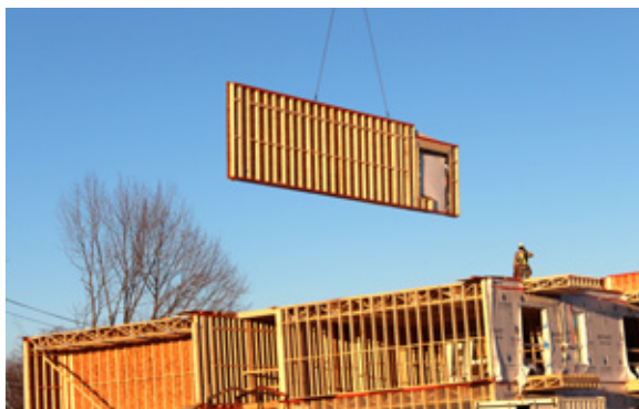
FIGURE 98 • Installation d'un mur préfabriqué (Photo : Cecobois)
