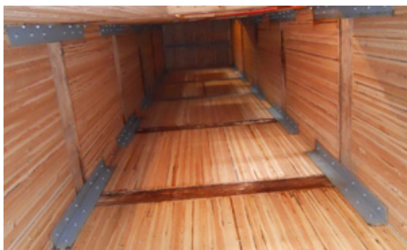
FIGURE 77 • Exemple d'une gaine d'ascenseur en bois de sciage lamellé-cloué (Photo: GHL Consultants Ltd.)
