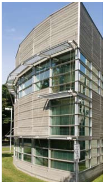
Le parement en bois massif des laboratoires de FPInnovations-Forintek à Québec a déjà 15 ans et son apparence est toujours de qualité.
