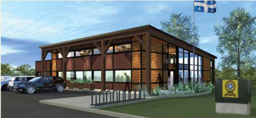
Poste de la Sûreté du Québec de Mékinac, Saint-Tite Architectes : Bilodeau Baril Architectes Associés • Ingénieurs : Pierre Gauvreau Expert-conseil Inc.
