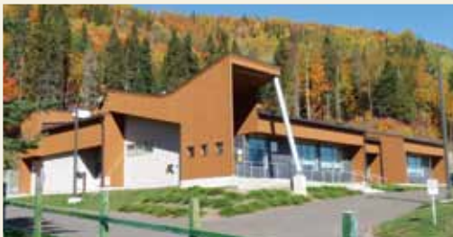
Poste de la Sûreté du Québec à Matapédia
