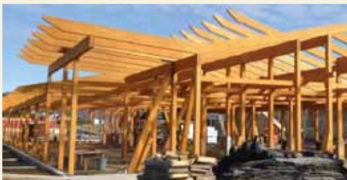
Poste de la Sûreté du Québec à Sainte-Agathe (pendant sa construction)
