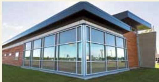
Poste de la Sûreté du Québec à Laurier-Station
