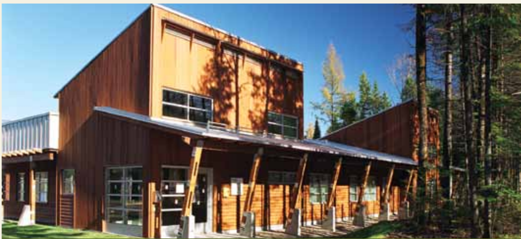
Poste de la Sûreté du Québec à Lac-Beauport Architectes : Lemay et associés • Ingénieurs : Genivar
