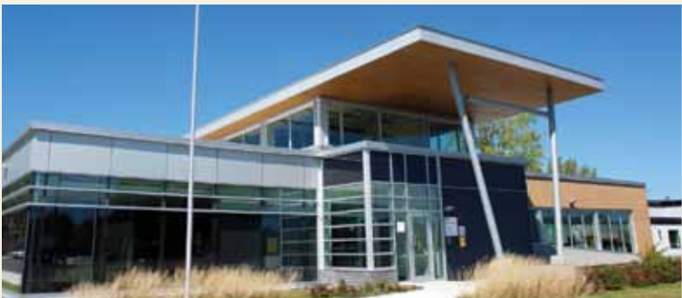
Poste de la Sûreté du Québec à Vaudreuil-Dorion
