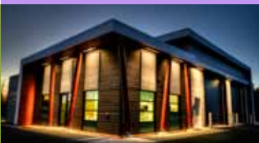
ÉDIFICE MTQ BERGERONNES Les Bergeronnes, Côte-Nord Groupe Conseil Planitech
