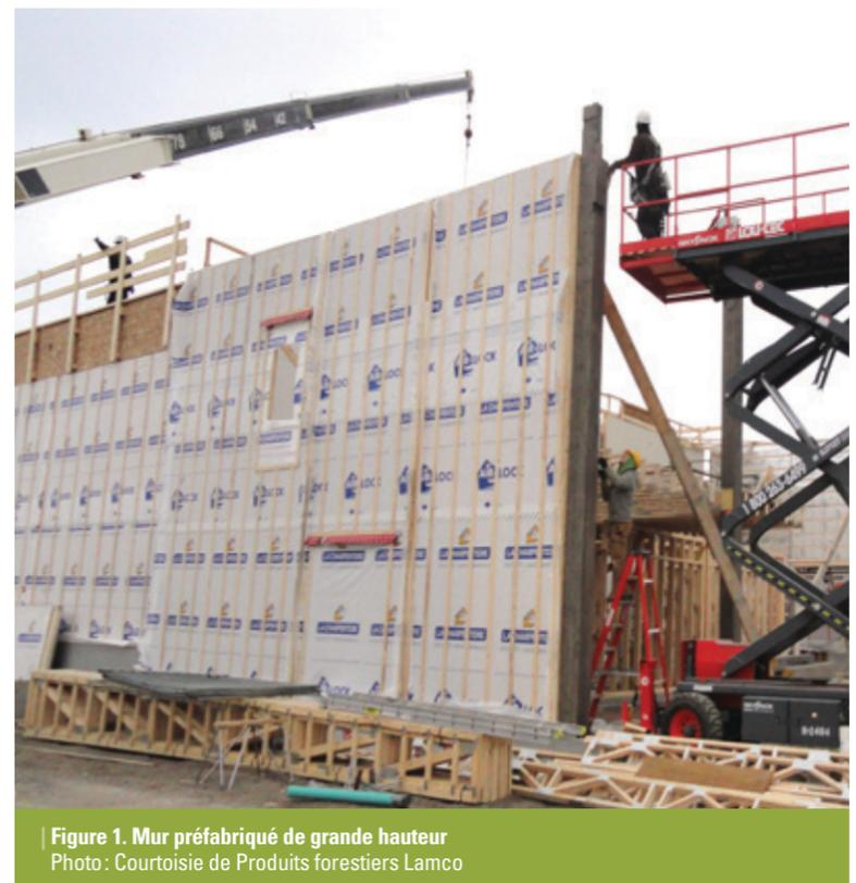
Figure 1. Mur préfabriqué de grande hauteur
