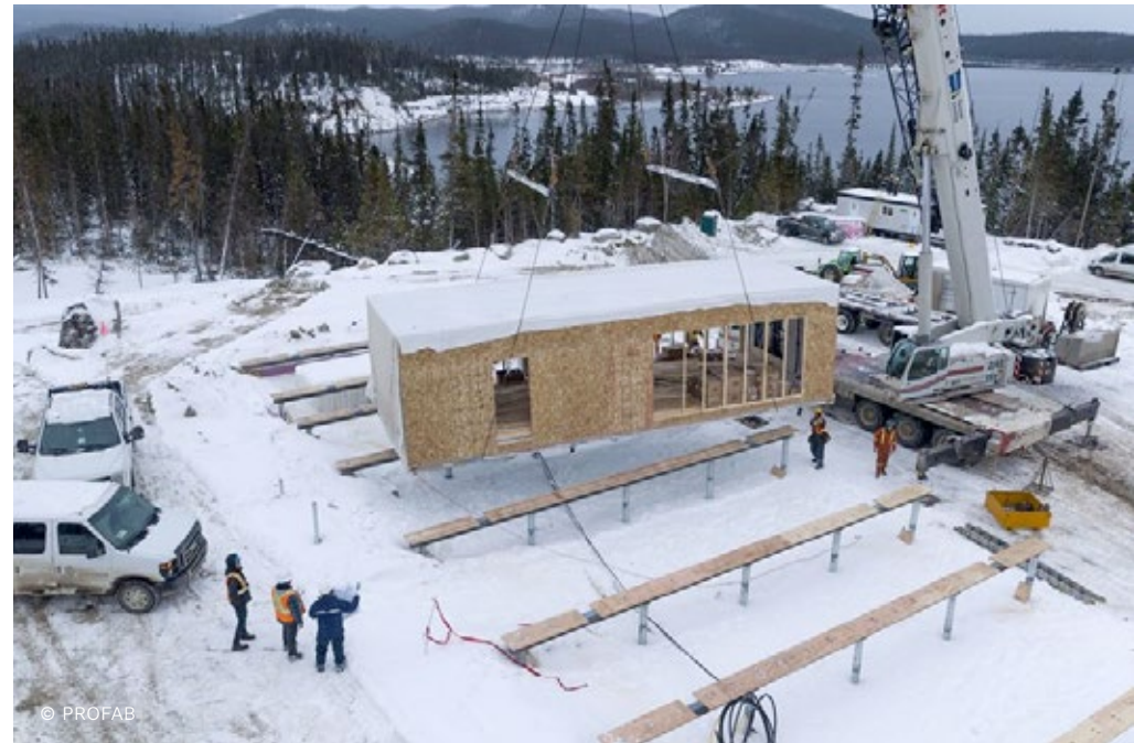
Installation des modules de l'auberge de la Station Uapishka par Pro-Fab.
