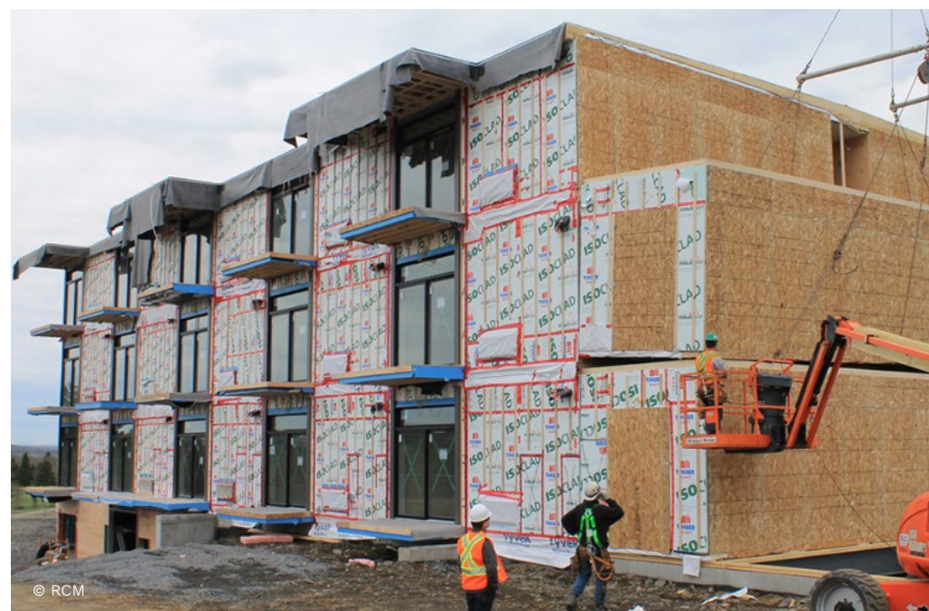
La Cache du golf de Beauceville en cours d'assemblage par Groupe RCM.
