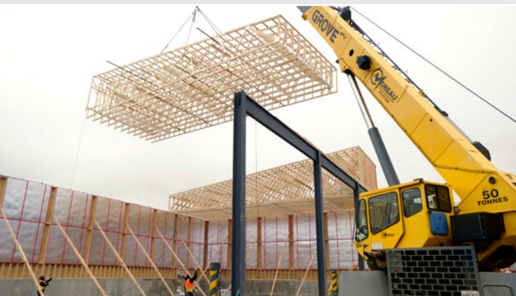
Installation de fermes de toit préfabriquées pour l'usine de CMAC Thyssen (Photo : Paul Brindamour)
