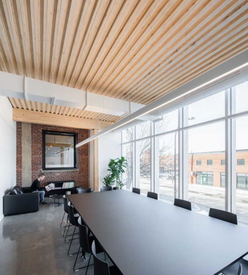
NLT (à partir de LVL) utilisé comme platelage d'une structure poteaux-poutres, dans les bureaux de Jodoin Lamarre Pratte, à Montréal (Photo : David Boyer)
