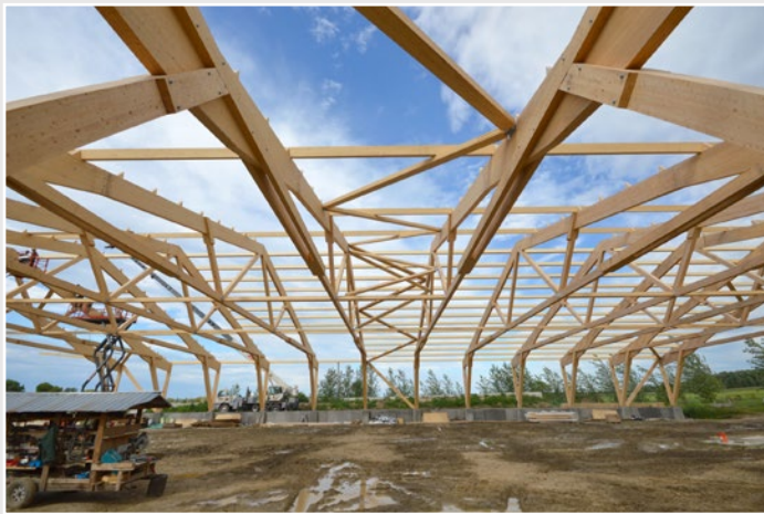
Fermes en bois lamellé-collé de la ferme biologique Zwyygart, Fortierville (Photo : Ambiance Bois)
