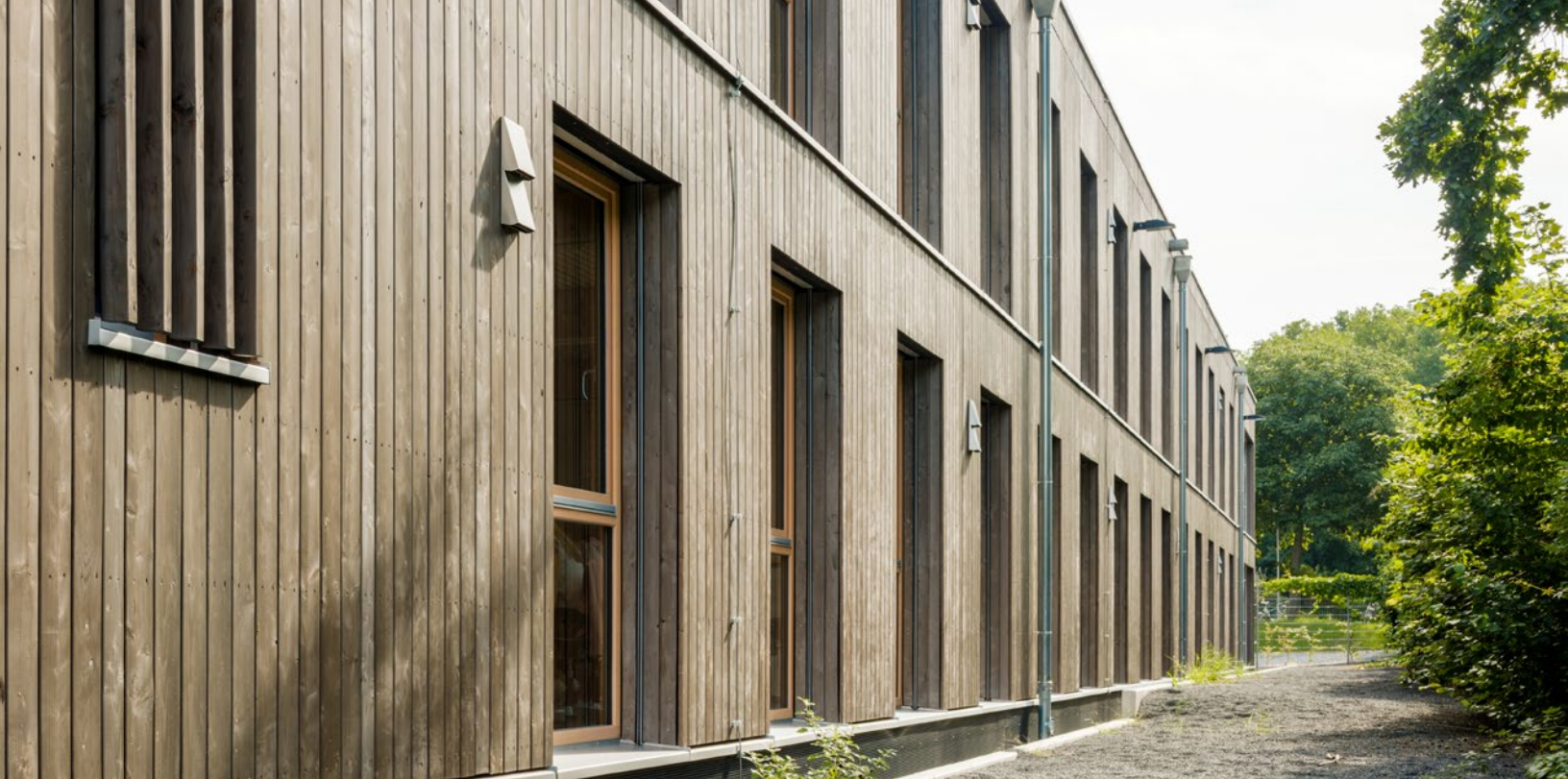
Revêtements extérieurs en bois massif, école Bertolt Brecht, Allemagne (Photo: Thomas Ott)
