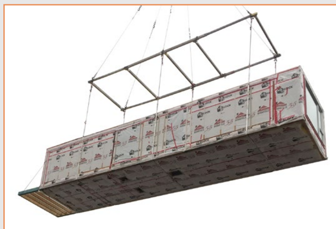
Installation d'un module d'une construction de type modulaire (Photo : cecobois)
