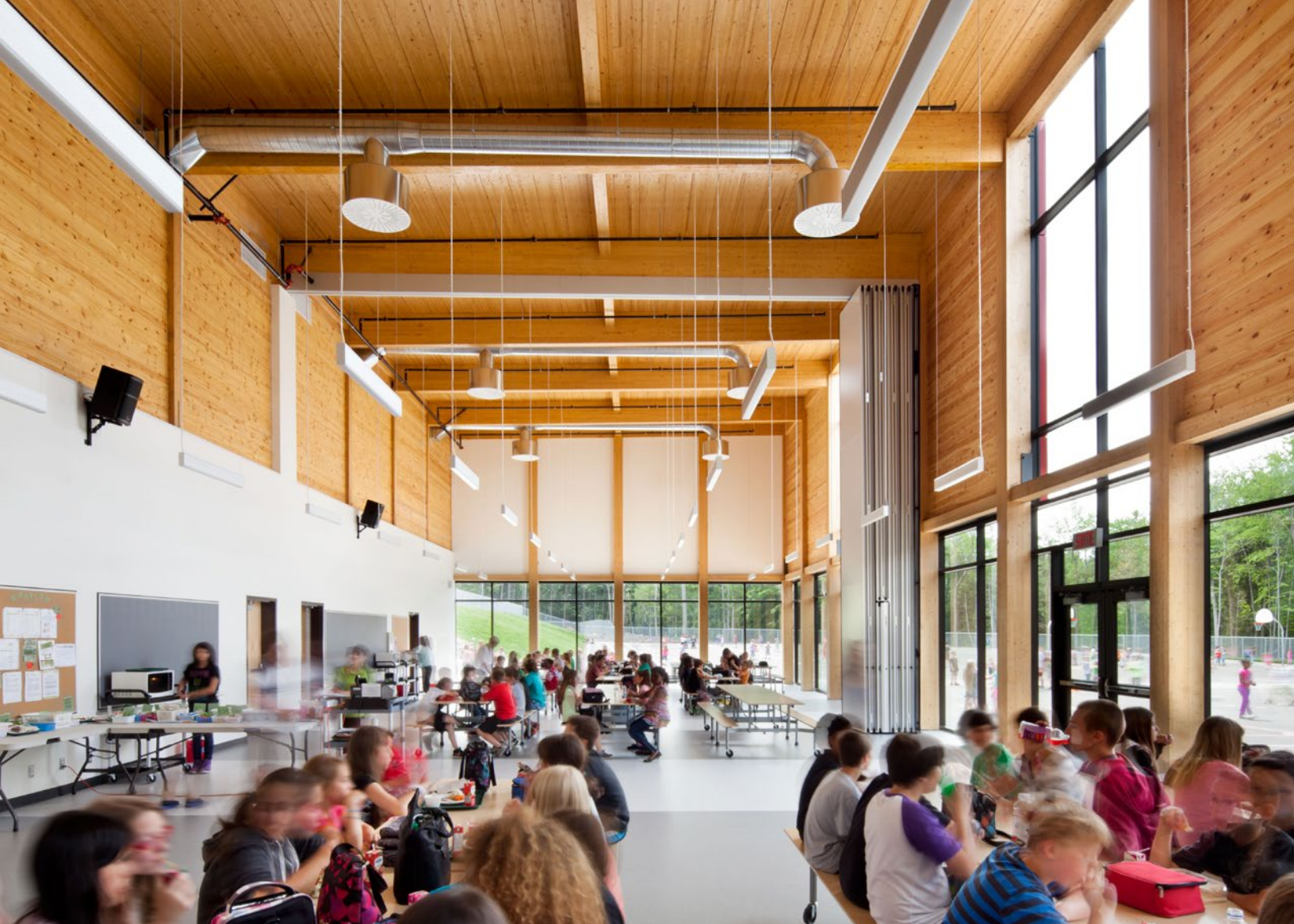
Système poteaux-poutres, école Sans-Frontières, Saint-Jérôme (Photo: Stéphane Brügger)
