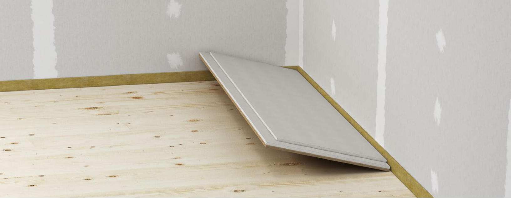
Installation de plaques de sol insonorisantes (Image : Fermacell, distribué au Canada par Distribution CC)
