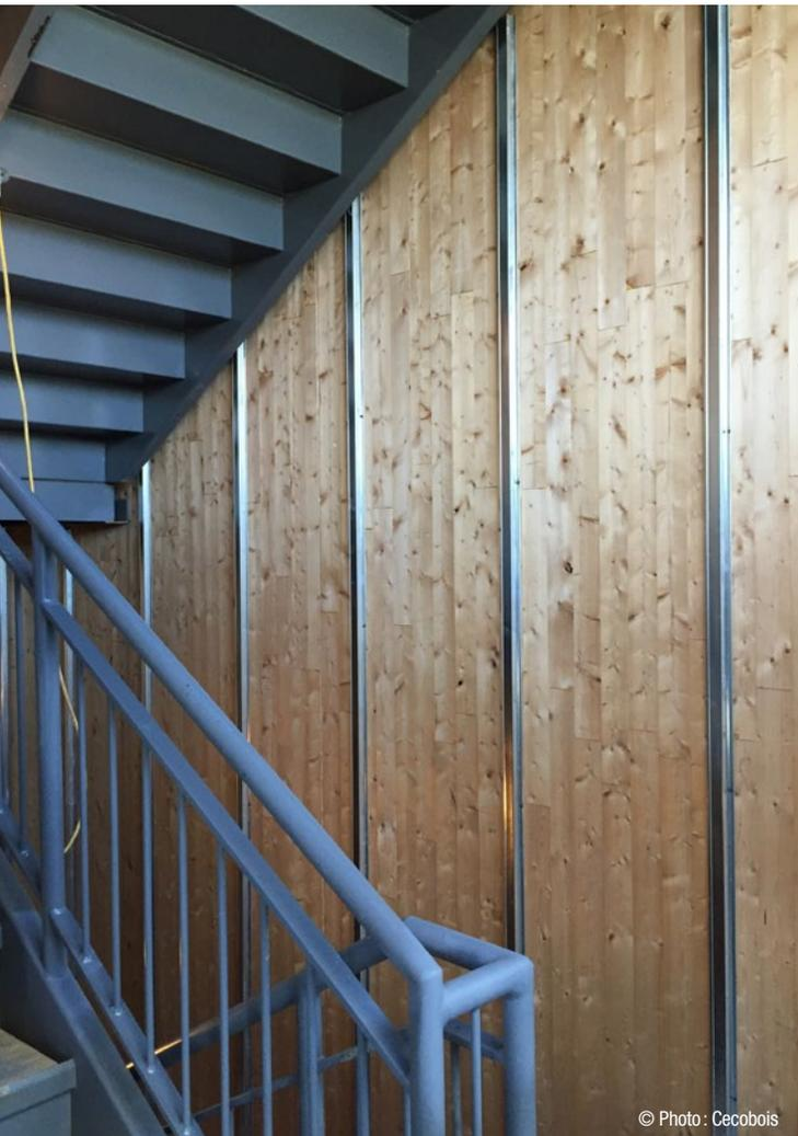
FIGURE 2 • Exemple d'une cage d'escalier en CLT
