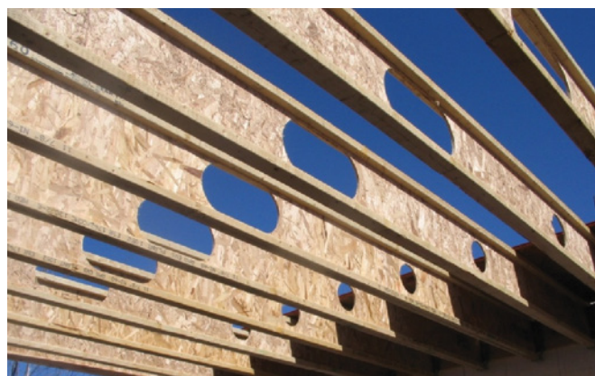
FIGURE 6 • Ouvertures préfabriquées dans le panneau d'âme
