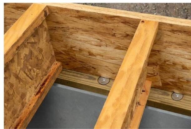
Figure 7 : Ancre Titen HD Washer-Head de Simpson Strong-Tie
