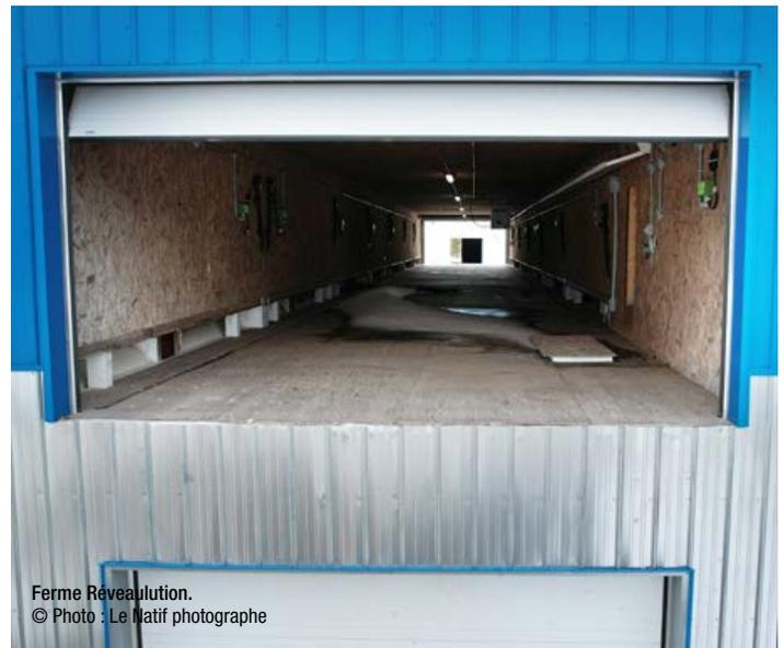
Les murs du corridor central servent de support intérieur pour les fermes de toits. Tous les murs sont constitués de 2 x 6 espacés de 609 mm et parés d'un OSB de 12,7 mm. Sur l'extérieur, ils sont isolés avec de la laine minérale pour une résistance R-20 et revêtus d'un revêtement extérieur métallique. Sur l'intérieur, des linteaux en LVL franchissent les portes des chambres.
