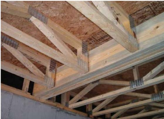
**FIGURE 7** • Poutrelles ajourées à connecteurs métalliques
