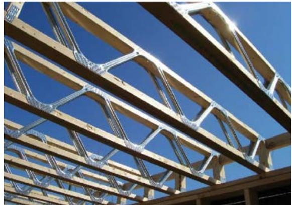
**FIGURE 8** • Poutrelles ajourées à âme métallique
