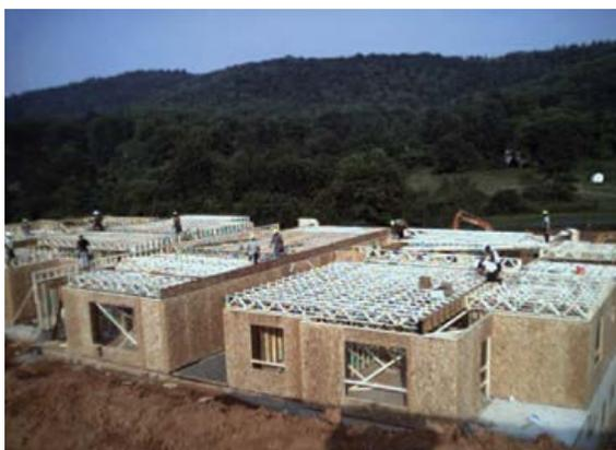
**FIGURE 10** • Système de plancher de poutrelles ajourées
