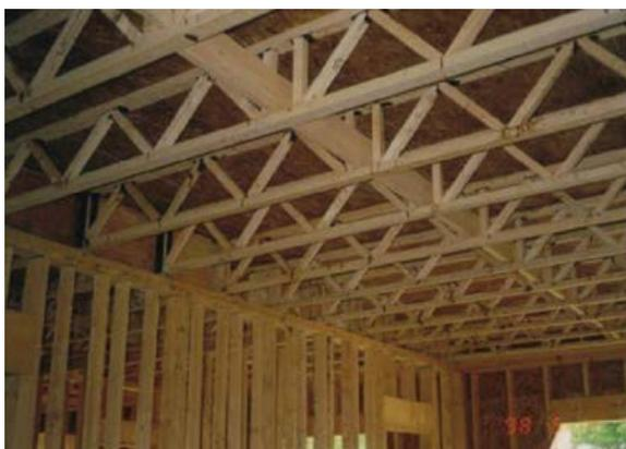
**FIGURE 9** • Poutrelles ajourées à âme de bois dentée et collée
