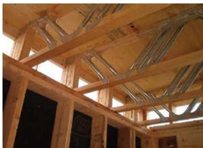
**FIGURE 19** • Doublage des diagonales
