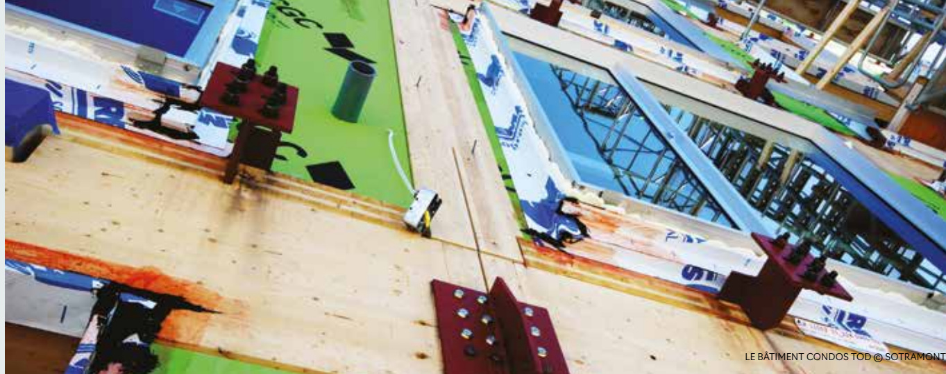
VU D'UN MUR DE REFEND EN CLT
