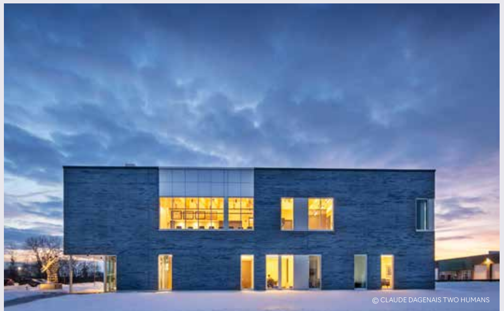
LE SIÈGE SOCIAL ET CENTRE DE FORMATION PROFESSIONNELLE DU LOCAL 144, PREMIER BÂTIMENT INDUSTRIEL LEED V4 PLATINE DU CANADA
