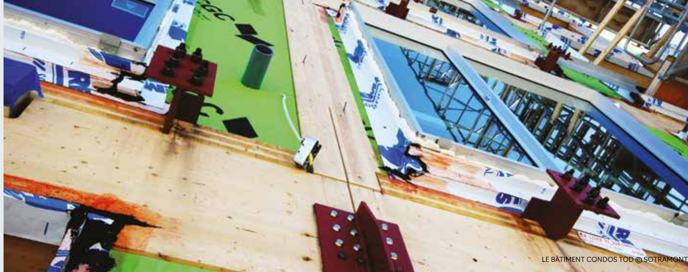
VU D'UN MUR DE REFEND EN CLT
