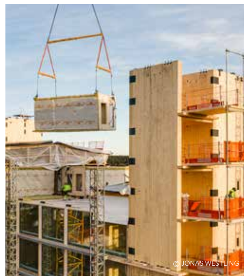
VUE AÉRIENNE DE LA CONSTRUCTION DU SARA CULTURAL CENTER
