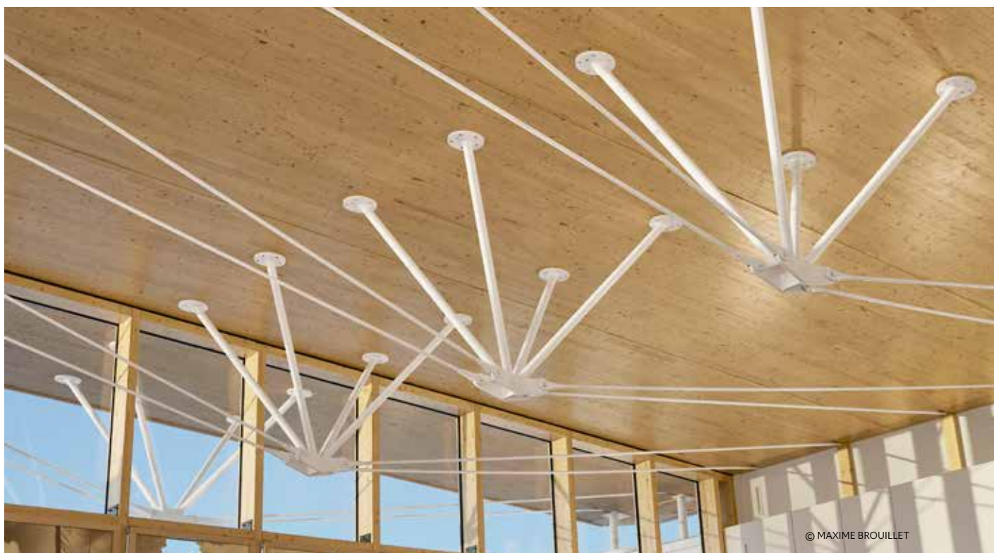
VUE DE L'INTÉRIEUR DE L'AÉROGARE DE CHIBOUGAMAU-CHAPAIS
