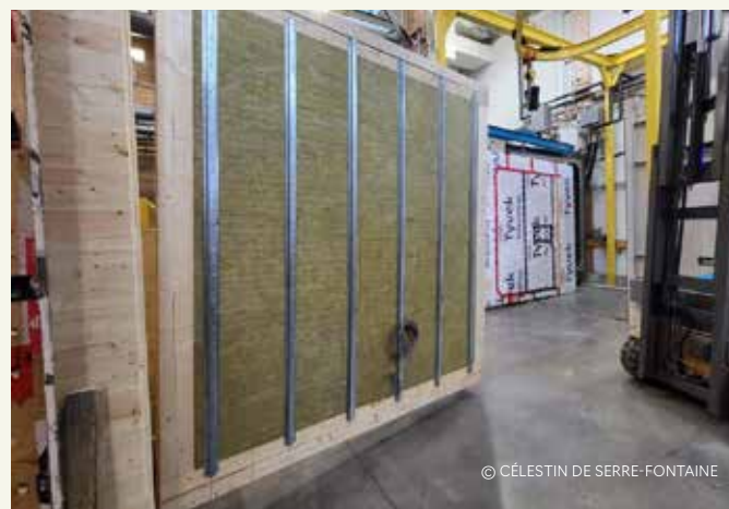
ENVELOPPES BIOSOURCÉES EN CLT
