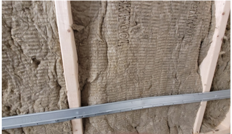
Figure 11. Barre résiliente endommagée.
