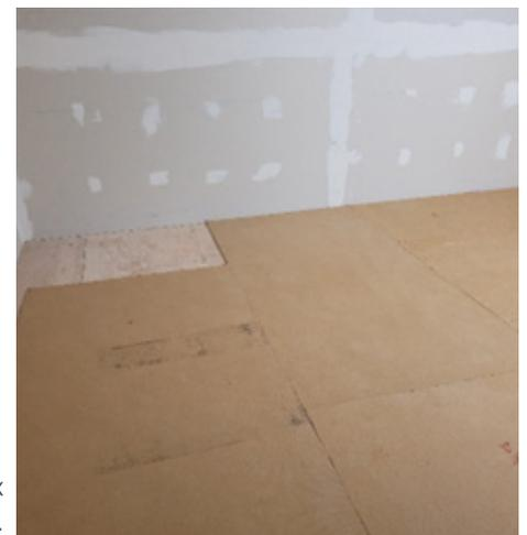
Figure 13. Installation adéquate des panneaux de fibre de bois sans vis sur le plancher.
