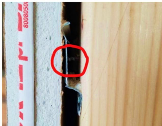
Figure 8. Mauvaise fixation du gypse à la paroi du mur.
