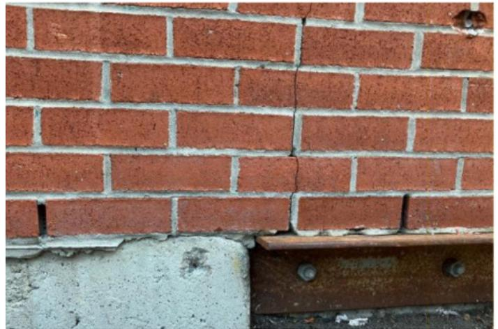
Figure 8. Fissuration causée par le changement de rigidité à l'appui [19]
