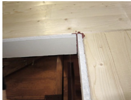
b) Pose des panneaux de gypse à l'intérieur de l'ouverture
