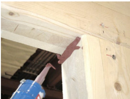
a) Installation du scellant coupe-feu dans les jonctions
