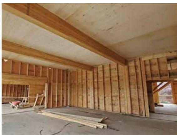
FIGURE 19 • Panneaux en CLT supportés par une structure à ossature légère en bois
