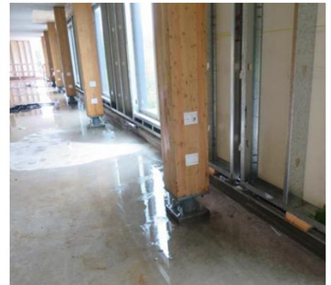
Figure 4. Eau stagnante sur chape de béton pendant la construction
