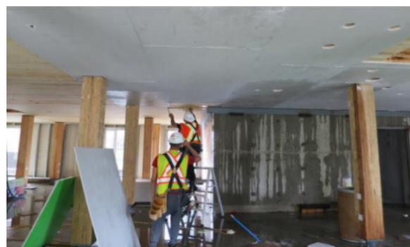
Figure 6. À éviter! Installation de cloisons sèches sur un plafond de CLT humide pendant la construction.
