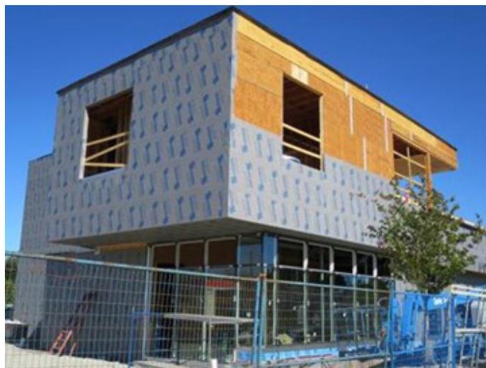
Figure 5. Membrane auto-adhésive perméable à la vapeur d'eau installée sur des murs en bois
