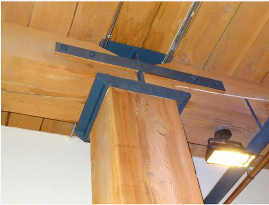
a) Assemblage traditionnel d'une construction en gros bois d'œuvre selon le CNB
