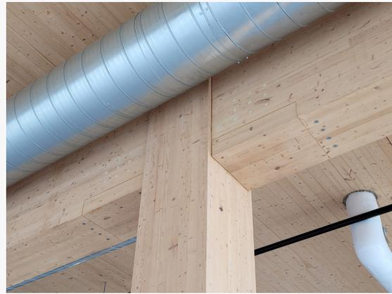
b) Assemblage moderne avec plaques d'appui dissimulées
