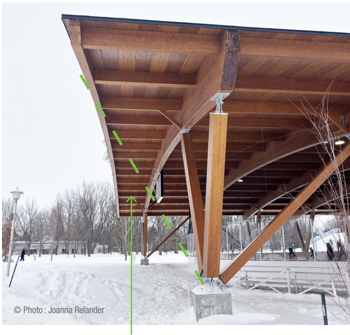
Débord de toit protégeant la poutre et les poteaux d'angle
