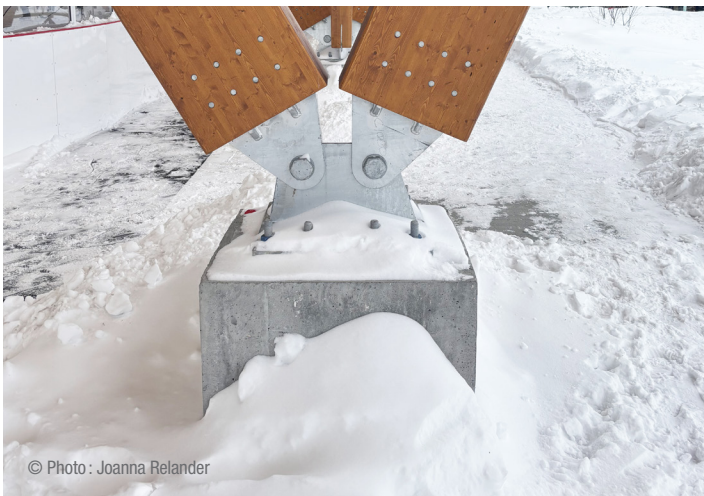
Pied de poteau surélevé et colonnes dissociées
