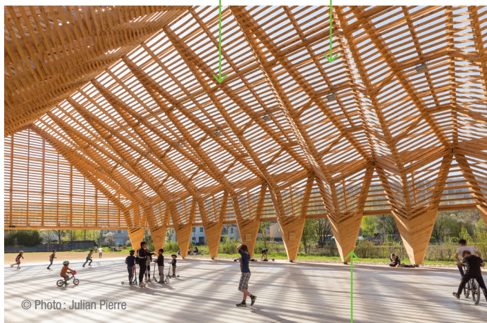
Bardage en bois d'œuvre sur la partie basse des portiques
