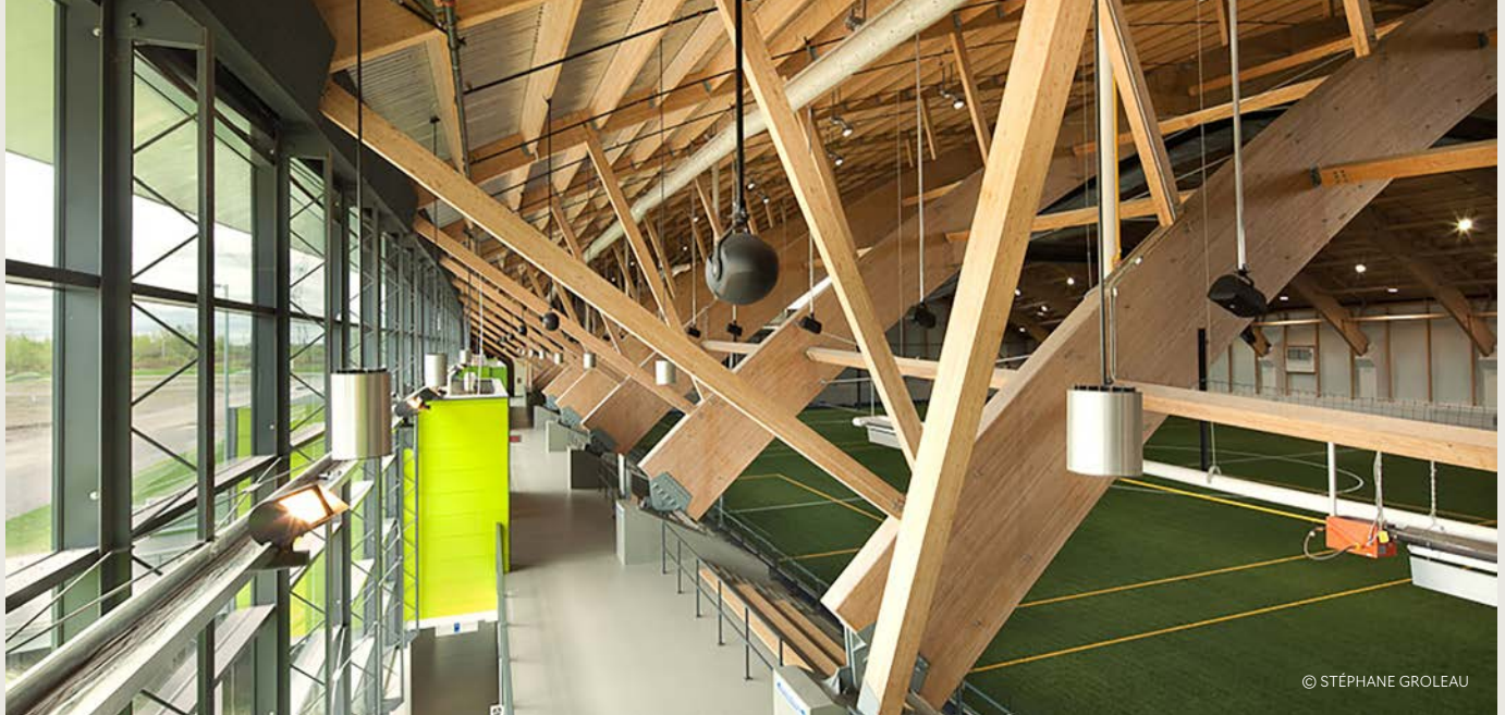
LE COMPLEXE DE SOCCER DE CHAUVEAU
