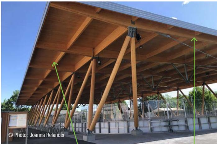
Sur les longues façades, les fermes en porte-à-faux supportent de grands débords de toiture qui protègent les assemblages des poutres ainsi que les poteaux jusqu'en pied.
