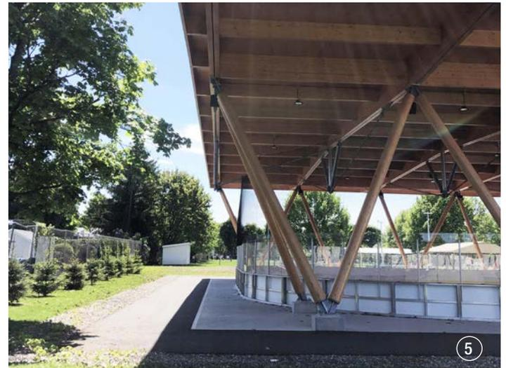
Pour que la protection des poteaux soit complète, le retrait doit être réalisé dans les deux directions dans les angles.
