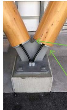
Poteau en bois surélevé de 60 cm du sol par ferrure et plot béton. La hauteur de la ferrure évite le rejaillissement depuis le plot béton
