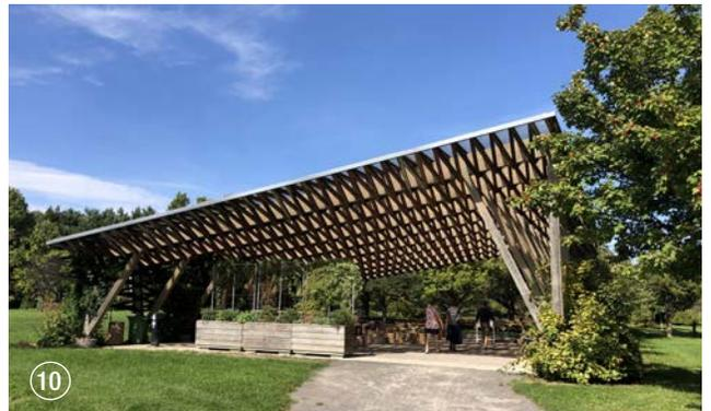
L'espace entre les poteaux évite l'accumulation d'eau dans le creux du V des poteaux en la laissant s'échapper par drainage. L'espace doit être suffisant pour permettre un séchage adéquat (1 cm minimum)
