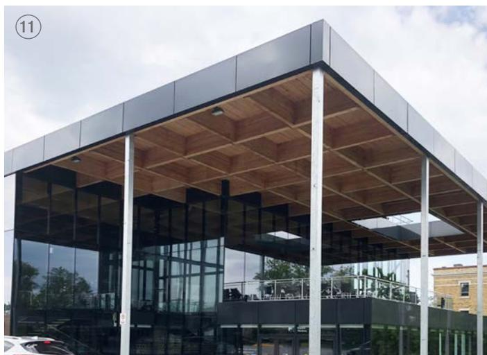
Dans cet édifice, le débord de toit en porte-à-faux protège bien les poutres périphériques et affine la rive, mais il est insuffisant pour mettre à l'abri les poteaux sur toute leur hauteur. L'équipe de projet a opté pour une solution de poteaux en acier.
