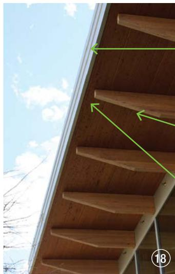
Solin métallique avec larmier recouvrant le complexe de toiture et le platelage bois
