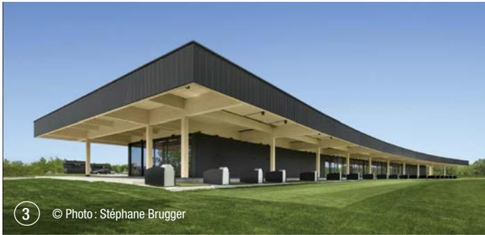
Dans la figure suivante, les poutres ont été prolongées en porte-à-faux pour soutenir le débord en panneaux de bois lamellé-croisé (NLT). Celui-ci protège ainsi les poteaux sur toute leur hauteur dans les deux directions.
