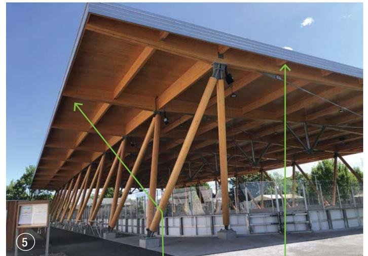
Les fermes intègrent de grands porte-à-faux qui prolongent la toiture et protègent les poutres, les assemblages et les poteaux sur toute leur hauteur.
