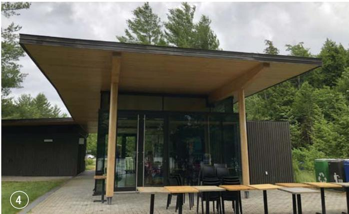
Dans la figure suivante, le débord en panneaux de bois lamellé-croisé CLT (ré-habillé en sous-face) permet de réaliser le porte-à-faux dans les 2 directions sans structure complémentaire. Les poutres périphériques, laissées apparentes et en retrait bénéficient ainsi d'une excellente protection. Le débord est cependant insuffisant pour protéger les poteaux sur toute leur hauteur jusqu'en pied. Sous la poutre bois, la structure est en acier.
