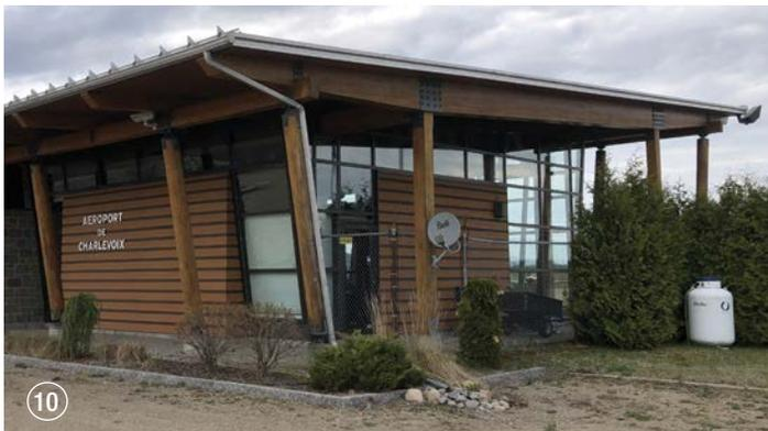
Écoulement direct depuis la toiture dans le fossé de graviers recevant et infiltrant l'eau pluviale dans le terrain, à distance des fondations. Passage piéton protégé par le toit.
