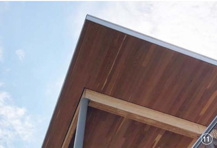
Assemblage en partie courante: les poutres sont disposées de manière à éviter l'exposition du bois de bout
