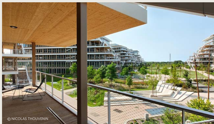
L'ARBORETUM DE NANTERRE EST LE PLUS GRAND CAMPUS EN BOIS D'EUROPE. LE CYCLE DE VIE DU CAMPUS ÉQUIVAUT À UNE RÉDUCTION DE 48% D'ÉMISSIONS CARBONE RELATIVEMENT À UNE CONSTRUCTION TRADITIONNELLE.
