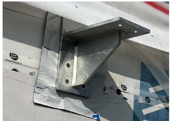
FIGURE 78 • Appui de balcon Crédit : Cecobois
