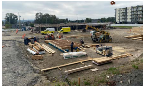
FIGURE 21 • Préfabrication de poutrelles de plancher, hôtel Home2Suites à Québec Crédit : Logisco
