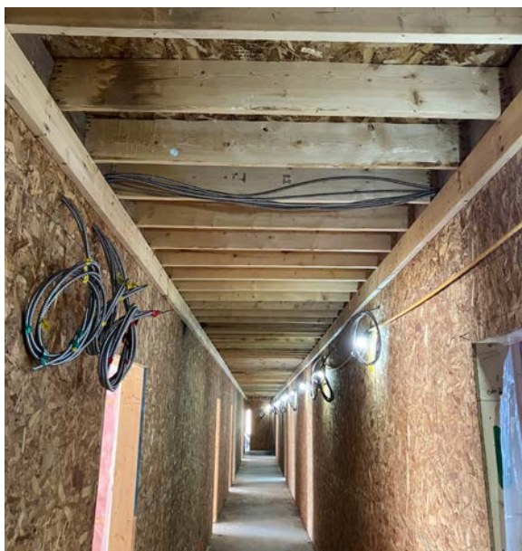
FIGURE 18 • Solives en bois de sciage dans le corridor
