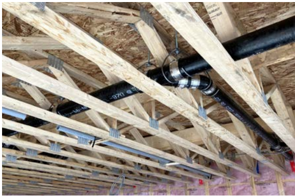
FIGURE 11 • Passage de la mécanique entre les poutrelles ajourées dans les deux directions Crédit : Cecobois
