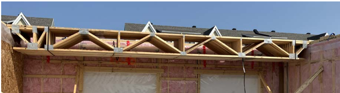
FIGURE 61 • Poutrelles appuyées par la semelle supérieure Crédit : Cecobois
