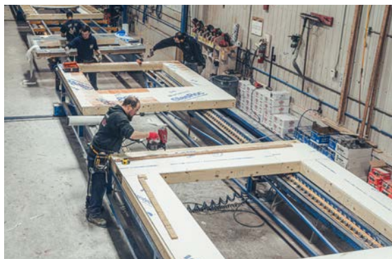
FIGURE 6 • Table d'assemblage de murs Crédit : Structures RBR
