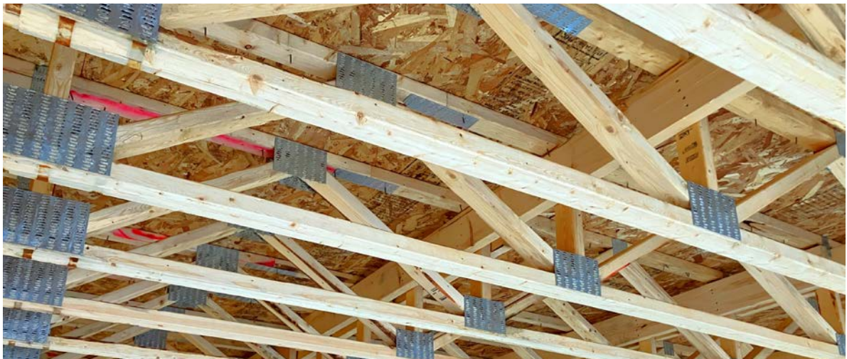
FIGURE 13 • Plancher de poutrelles ajourées avec lien continu Crédit : Cecobois
