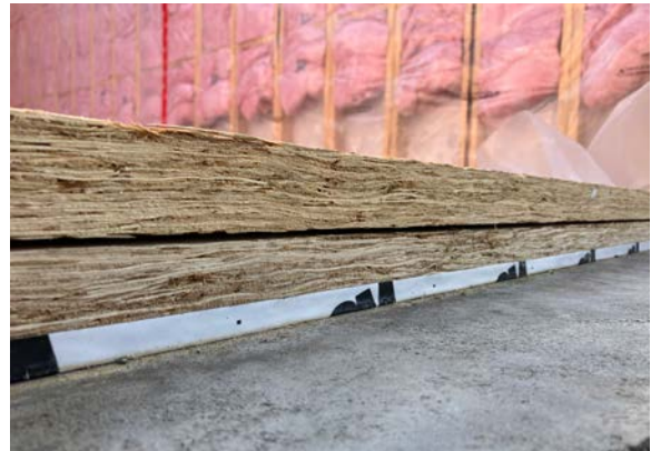
FIGURE 38 • Membrane sous la lisse installée au chantier Crédit : Cecobois
