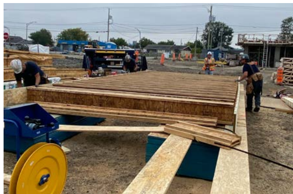
FIGURE 22 • Préfabrication de poutrelles de plancher, hôtel Home2Suites à Québec Crédit : Logisco
