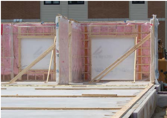
FIGURE 37 • Première lisse installée sur le béton Crédit : Cecobois
