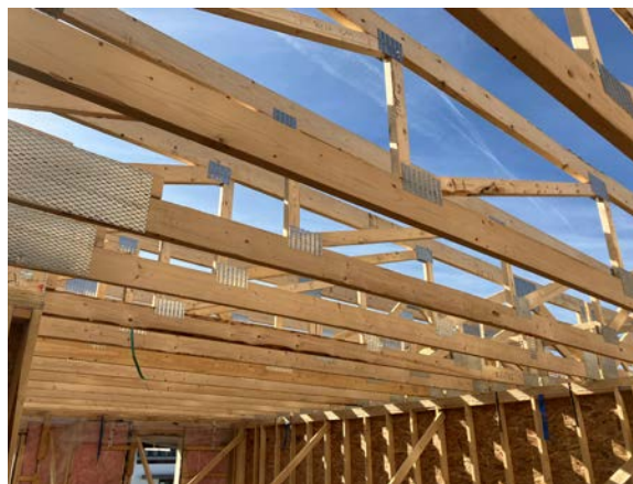
FIGURE 3 • Fermes de toit Crédit : Cecobois
