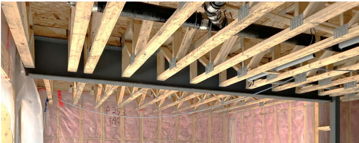
FIGURE 31 • Système poteaux-poutres au rez-de-chaussée sous mur porteur
