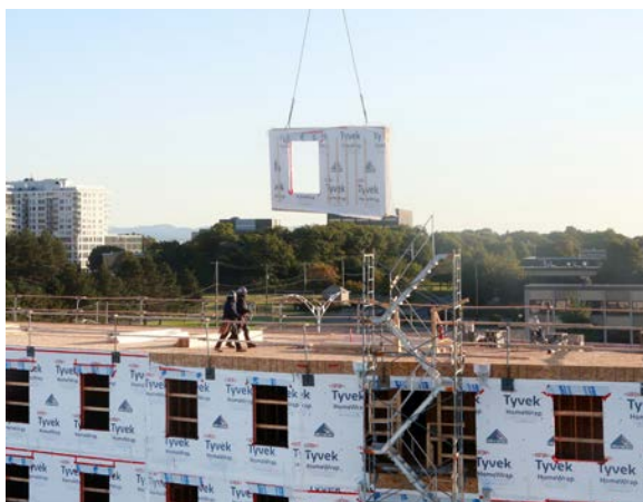
FIGURE 1 • Murs préfabriqués livrés au chantier Crédit : Cecobois
