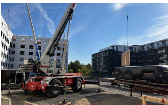
FIGURE 7 • Grue mobile Crédit : Cecobois
