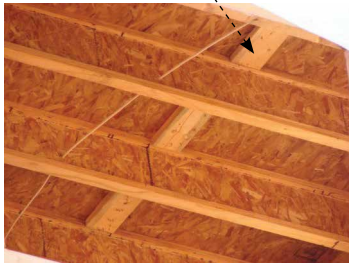
Figure 52 • Exemple de blocage de diaphragme
